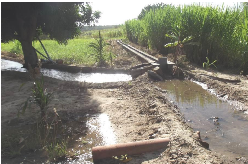
Figura 5 - Uso do canal de irrigação do DNOCS para inundar área irrigada (Fonte: Hermilson Barros, 2013)
