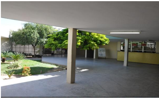
Figura 21- Lâmpadas acesas na entrada do Restaurante Universitário, Campus do Pici , UFC. Fortaleza-CE
