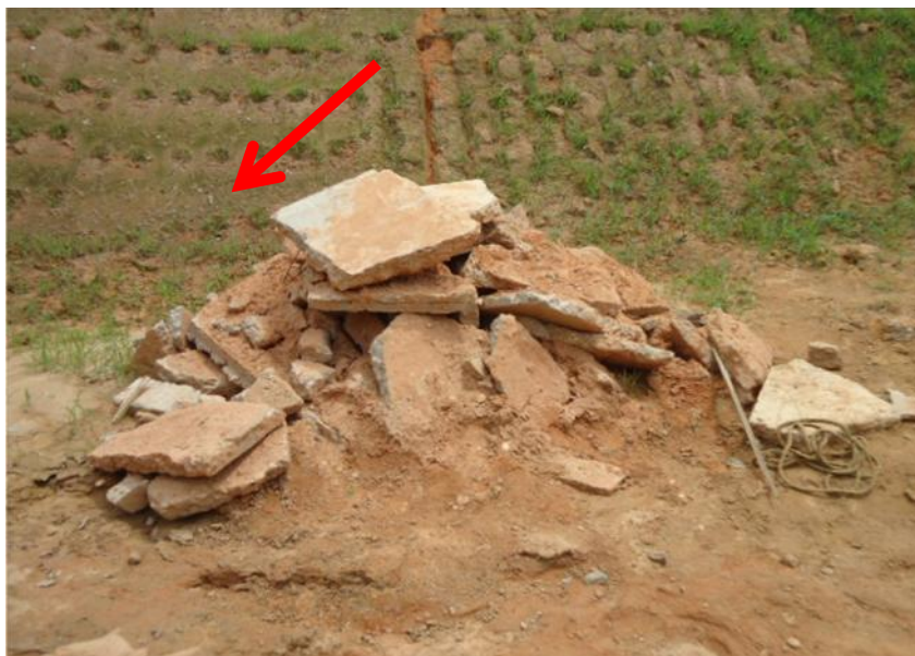
Figura 7 – Resíduos de demolição de concreto dispostos em local inadequado.
