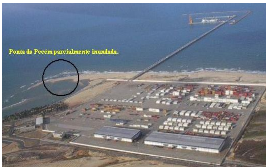
Figura 6 – Ponta do Pecém parcialmente inundada na preamar.
