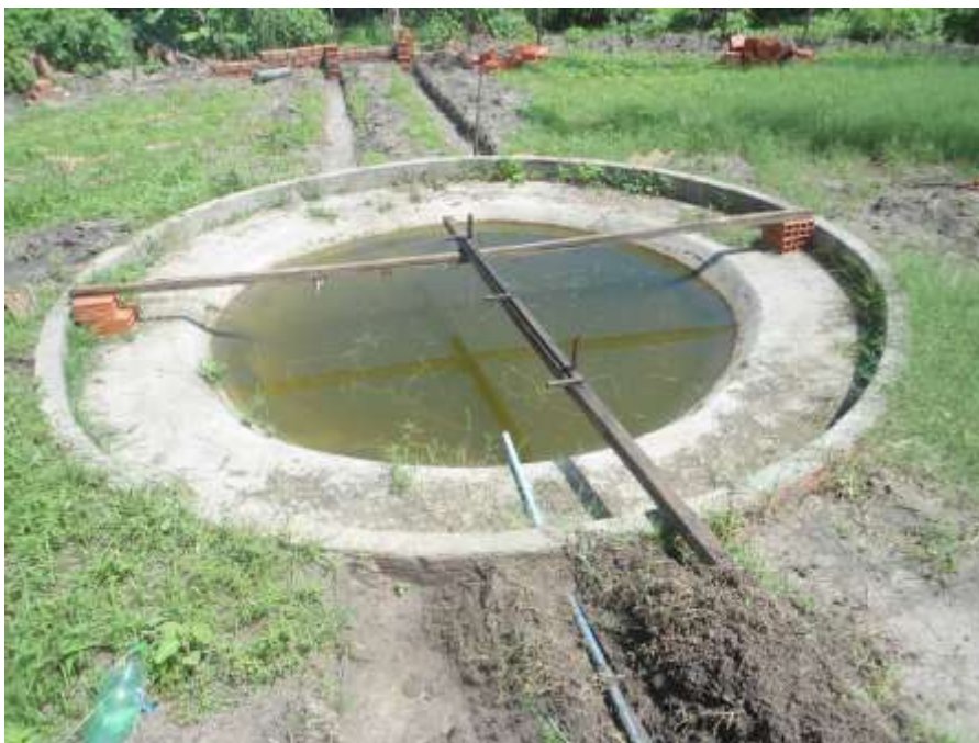
Figura 17: Reservatório superficial de água
