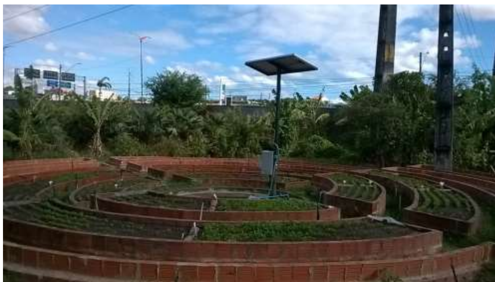
Figura 38: Unidade de produção instalada
