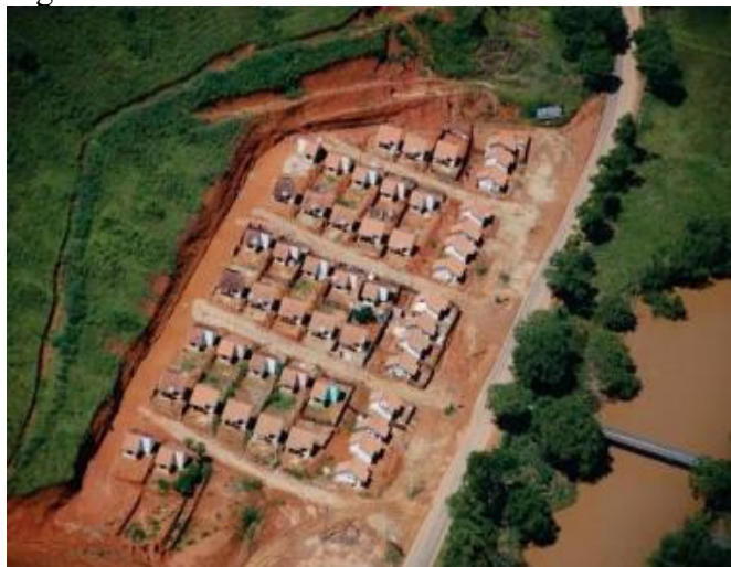
Figura 32 – Bairro Loteamento Ilha
