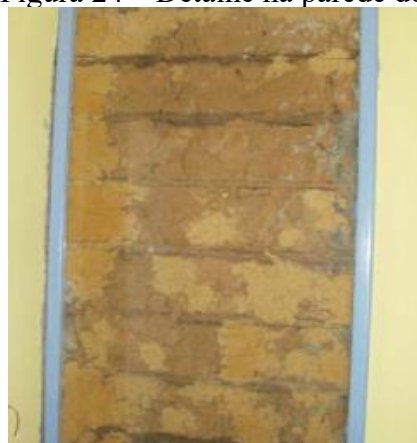
Figura 24 – Detalhe na parede do casarão
