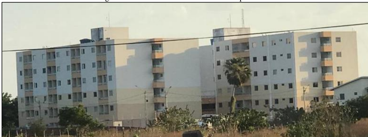
Figura 17 – Condomínio em frente ao Campus UFC Russas
