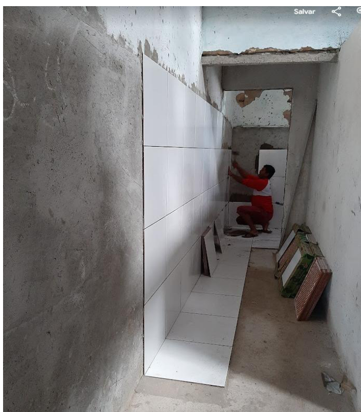
Foto 10 - Obra de requalificação da Escola Quintino Cunha
