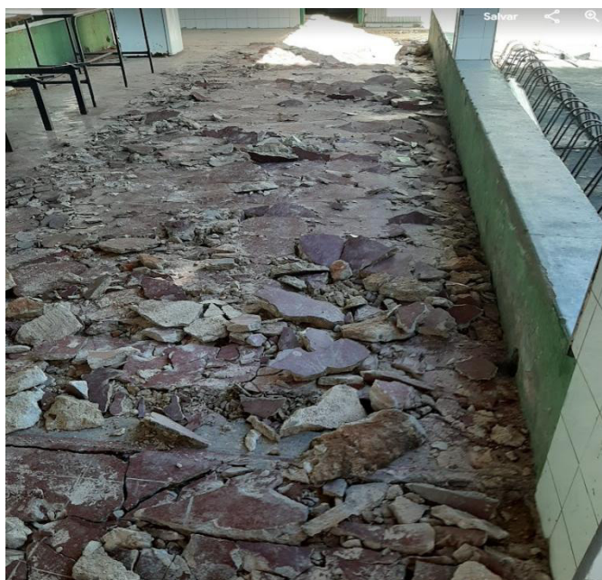
Foto 03 - Obra de requalificação da Escola Quintino Cunha
