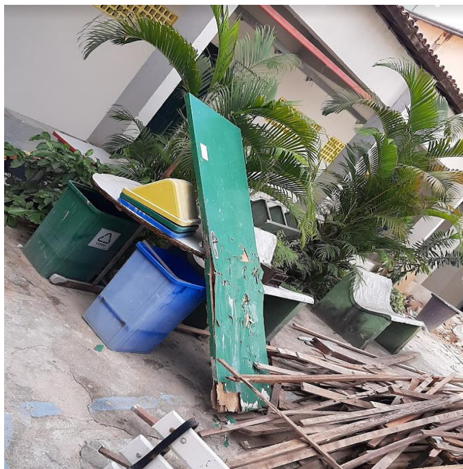
Foto 05 - Obra de requalificação da Escola Quintino Cunha
