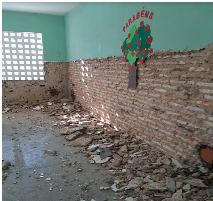
Foto 07 - Obra de requalificação da Escola Quintino Cunha
