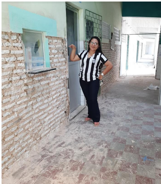
Foto 01 - Obra de requalificação da Escola Quintino Cunha
