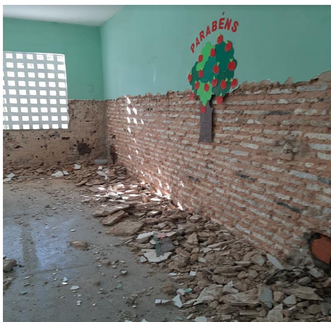
Foto 04 - Obra de requalificação da Escola Quintino Cunha
