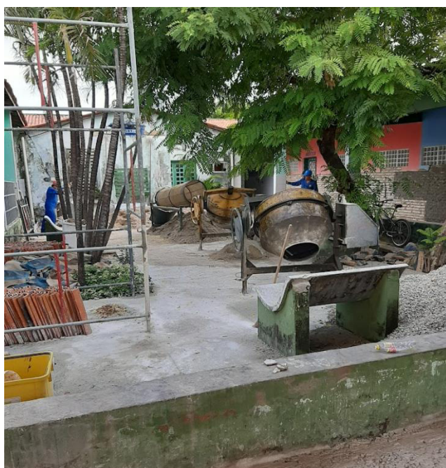
Foto 02 - Obra de requalificação da Escola Quintino Cunha
