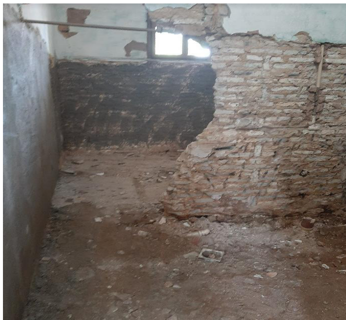
Foto 09 - Obra de requalificação da Escola Quintino Cunha
