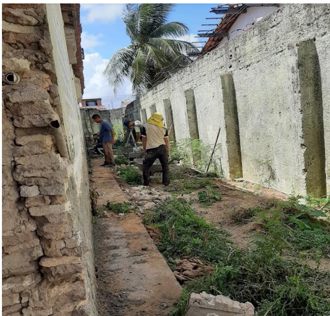
Foto 08 - Obra de requalificação da Escola Quintino Cunha
