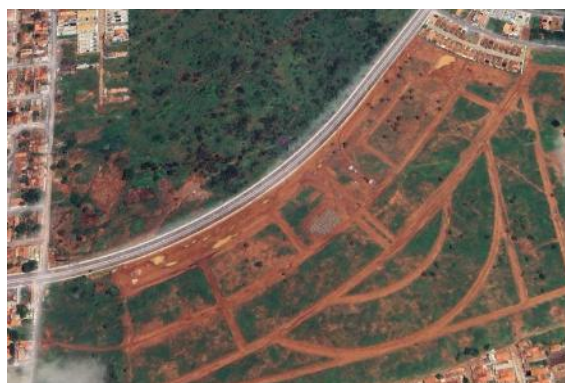
Figura 104: Parcelamento condomínio Le Jardin: área toda desmatada.
