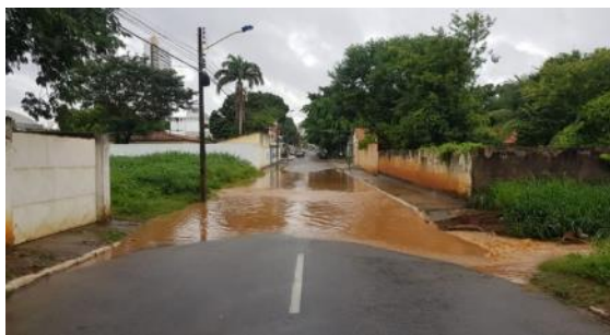
Figura 99: Alagamento Rua Arnóbio Bacelar Caneca, Lagoa Seca
