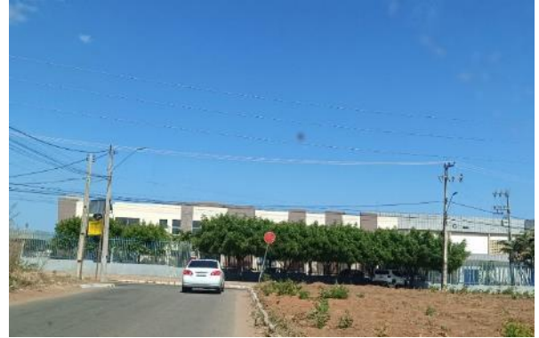
Figura 93: Distribuidora Coca-Cola, quarteirão industrial Bairro Planalto.
