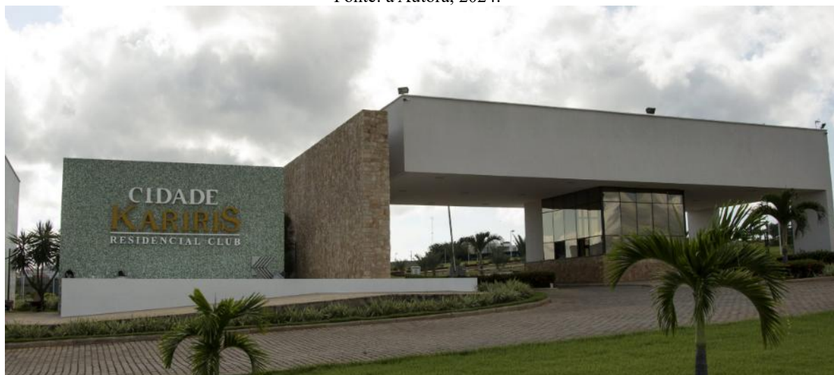
Figura 112: Portaria Condomínio Cidade Kariris (Barbalha) Fonte: Kariris Empreendimentos, 2024.
