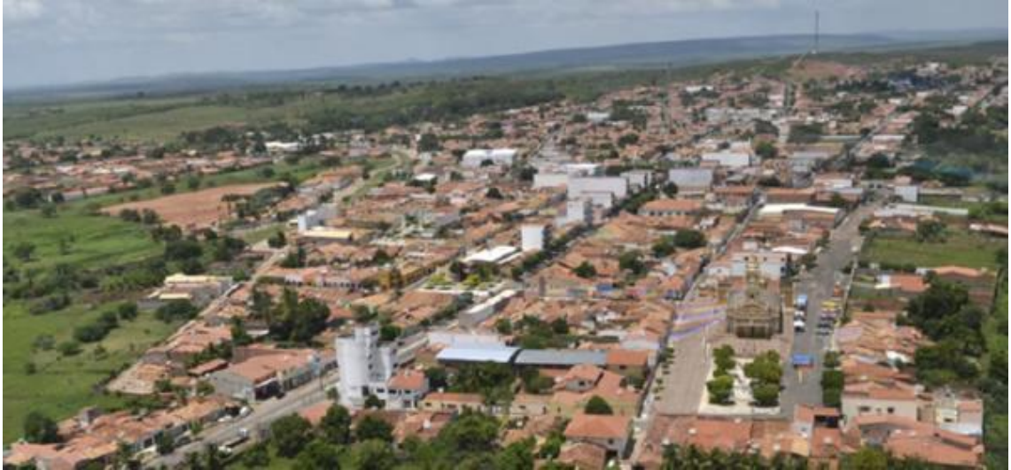
Figura 24: Vista de Missão Velha Fonte: Câmara Municipal, 2022.
