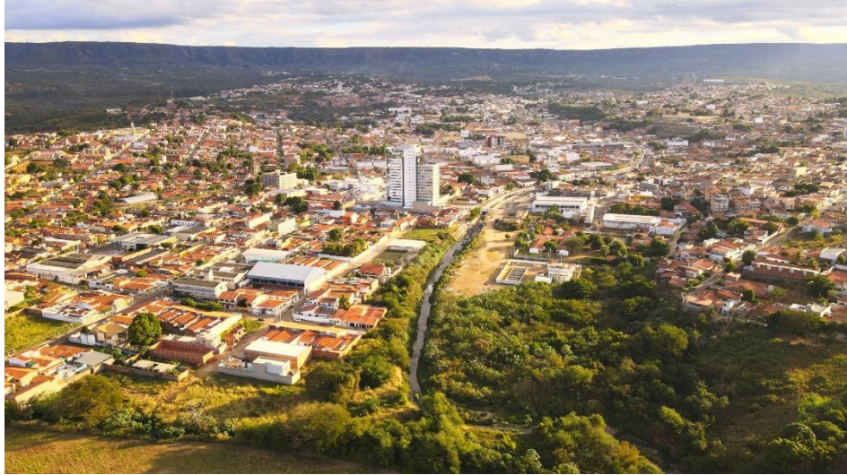
Figura 19: Vista aérea do Crato Fonte: Ambiental Ceará, 2022.
