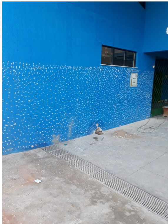
Fotografia 06 – Intervenções realizadas na área externa da escola
