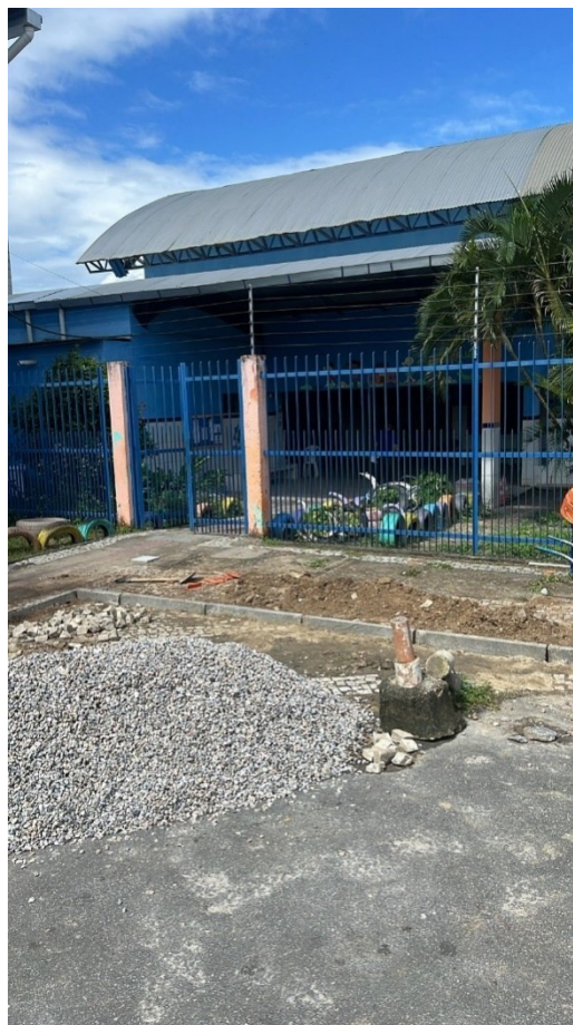
Fotografia 04 – Reformas realizadas na área externa da escola
