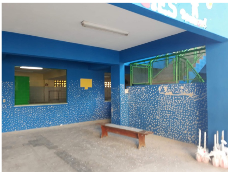
Fotografia 07 – Reformas realizadas na área externa da escola
