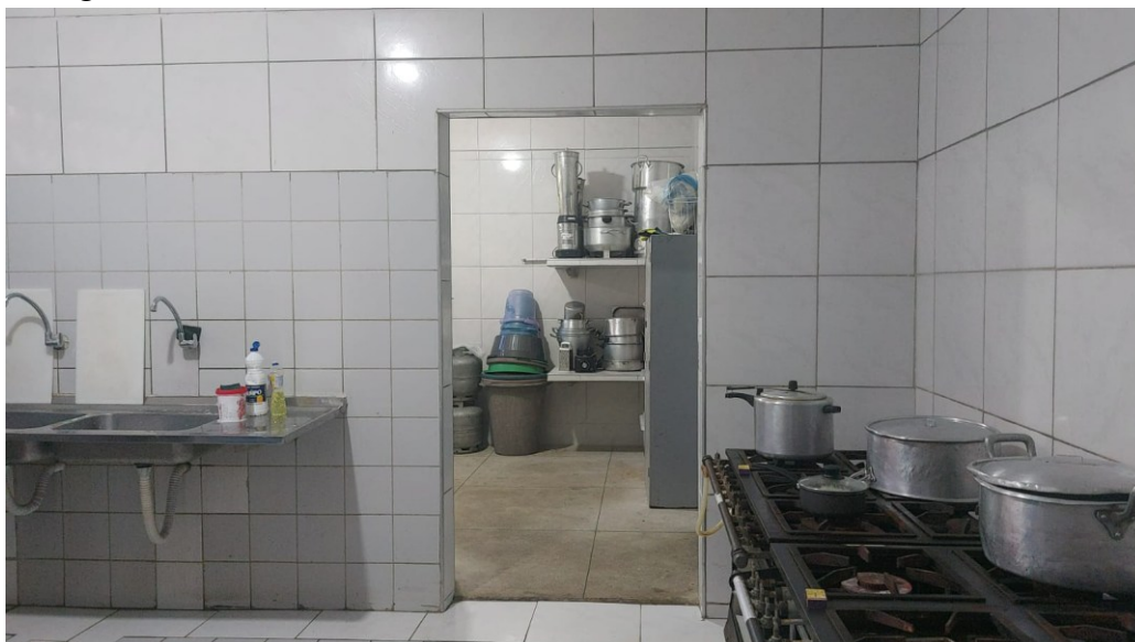
Fotografia 02 – Referida reforma concluída na cozinha da escola
