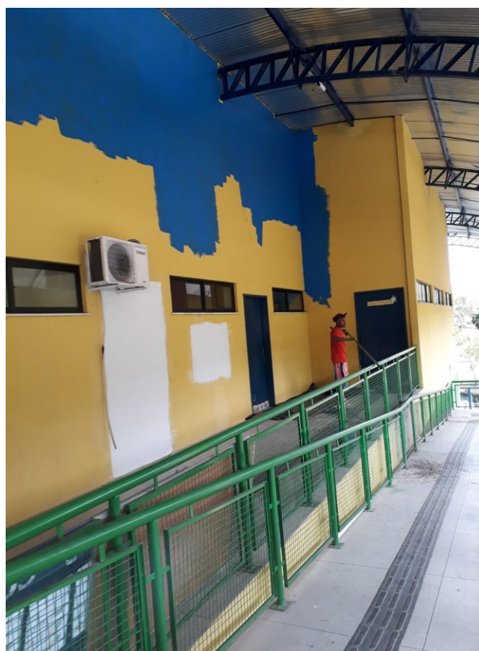
Fotografia 03 – Reformas realizadas no pátio da escola
