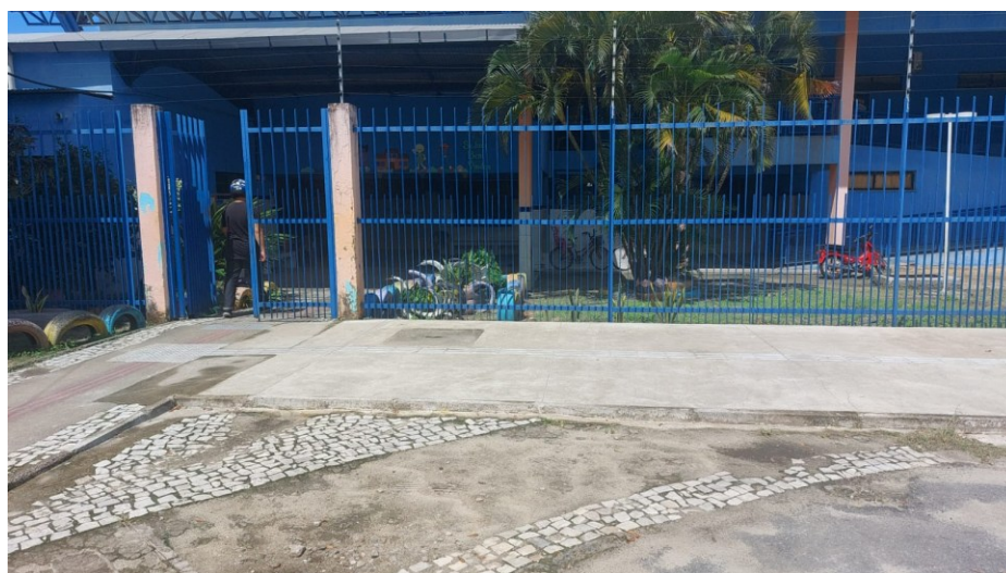
Fotografia 05 – Referida reforma concluída na área externa da escola
