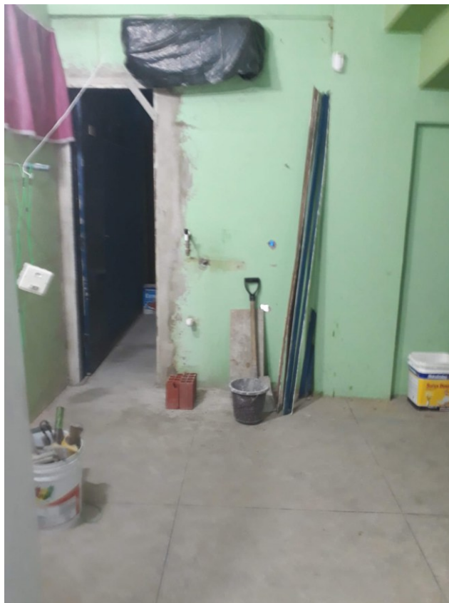
Fotografia 08 – Reformas realizadas na sala de professores
