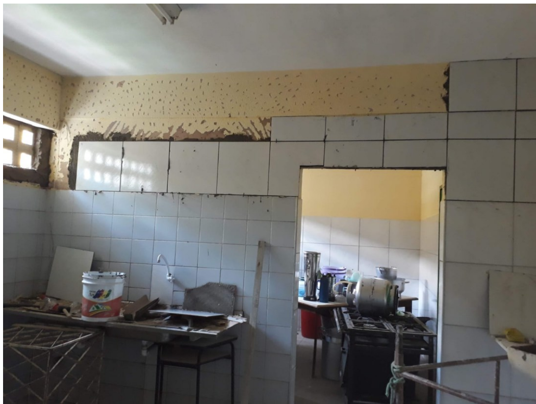
Fotografia 01 – Reformas em andamento na cozinha da escola
