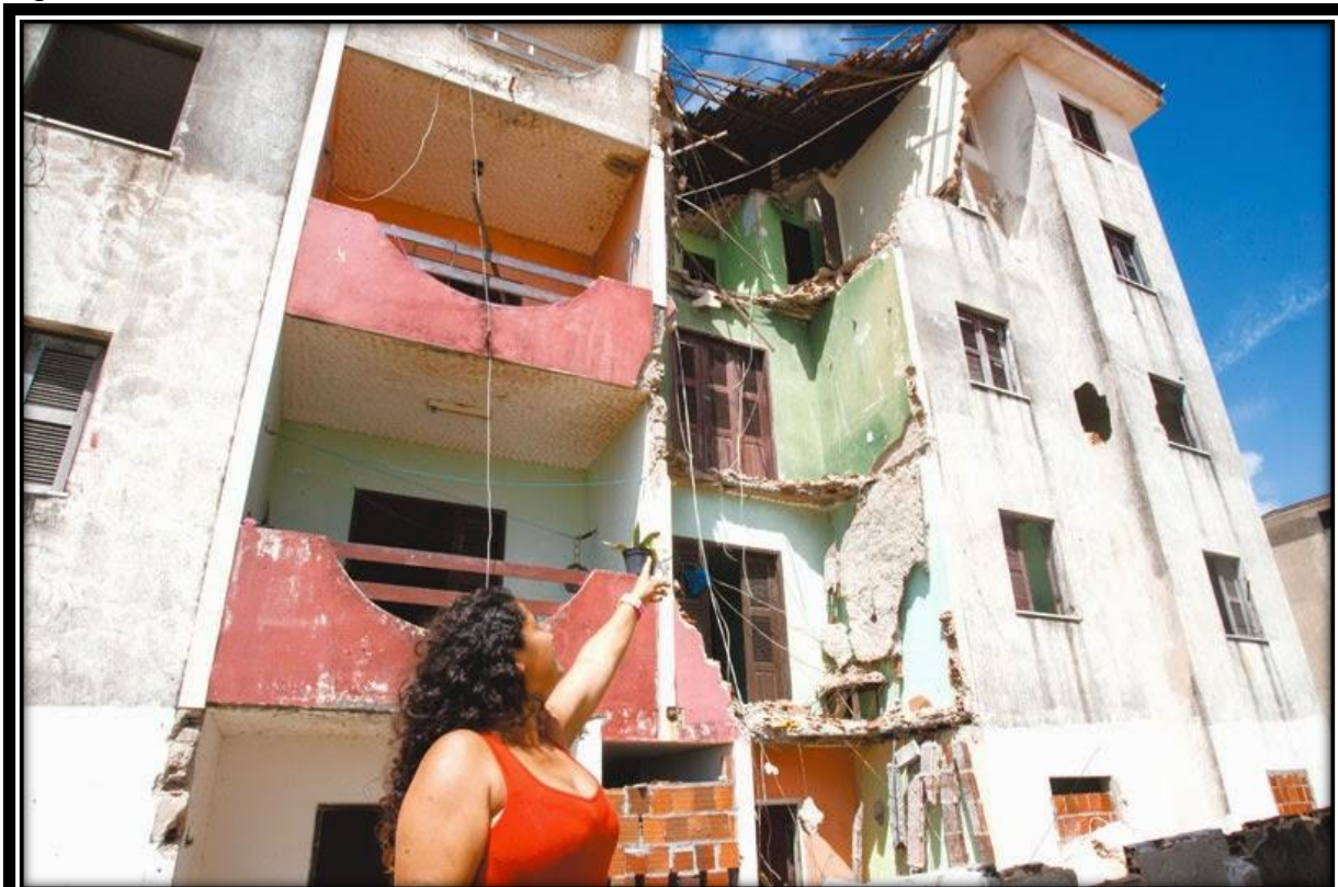
Figura 10 – Edifício Alto da Prainha
