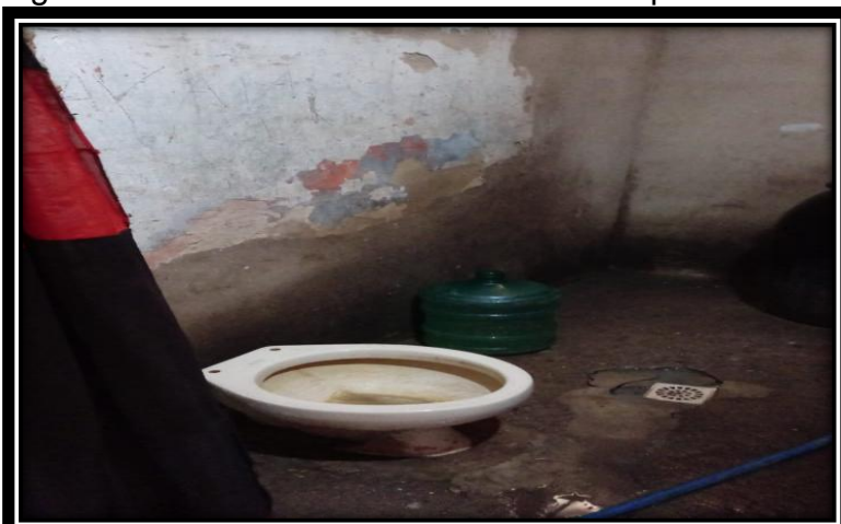
Figura 20 – Banheiro da casa de Guadalupe
