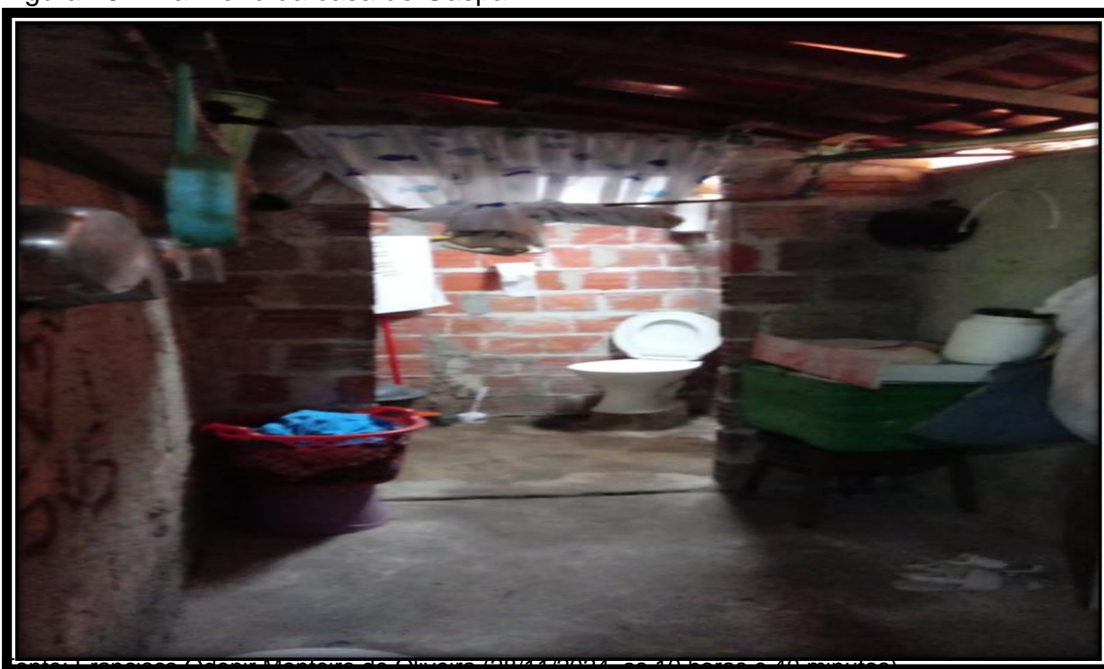
Figura 16 – Banheiro da casa de Gaspar
