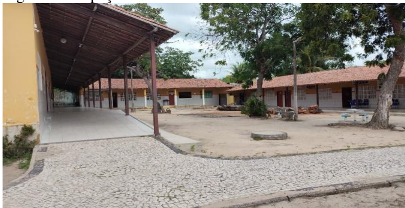
Figura 6 – Espaço referente às salas de aula da escola
