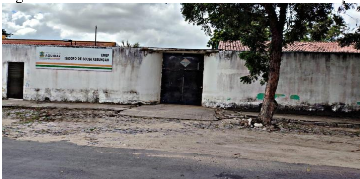
Figura 3 – Fachada da EMEF Isidoro de Sousa Assunção
