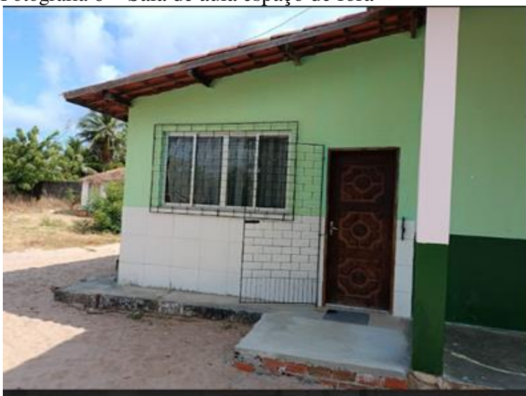
Fotografia 6 – Sala de aula espaço de fora
