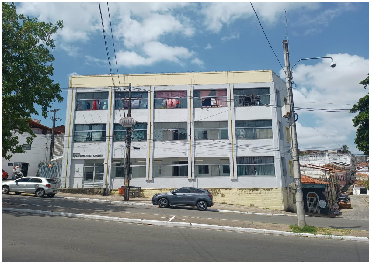
Figura 27 – Edifício Governador Archer
