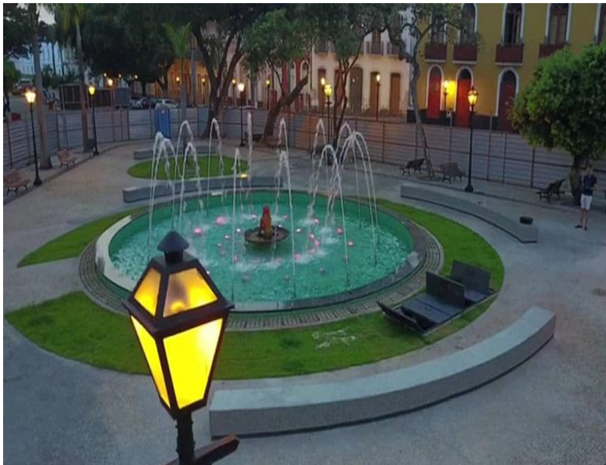
Figura 41 – Praça Dom Pedro II após reforma
