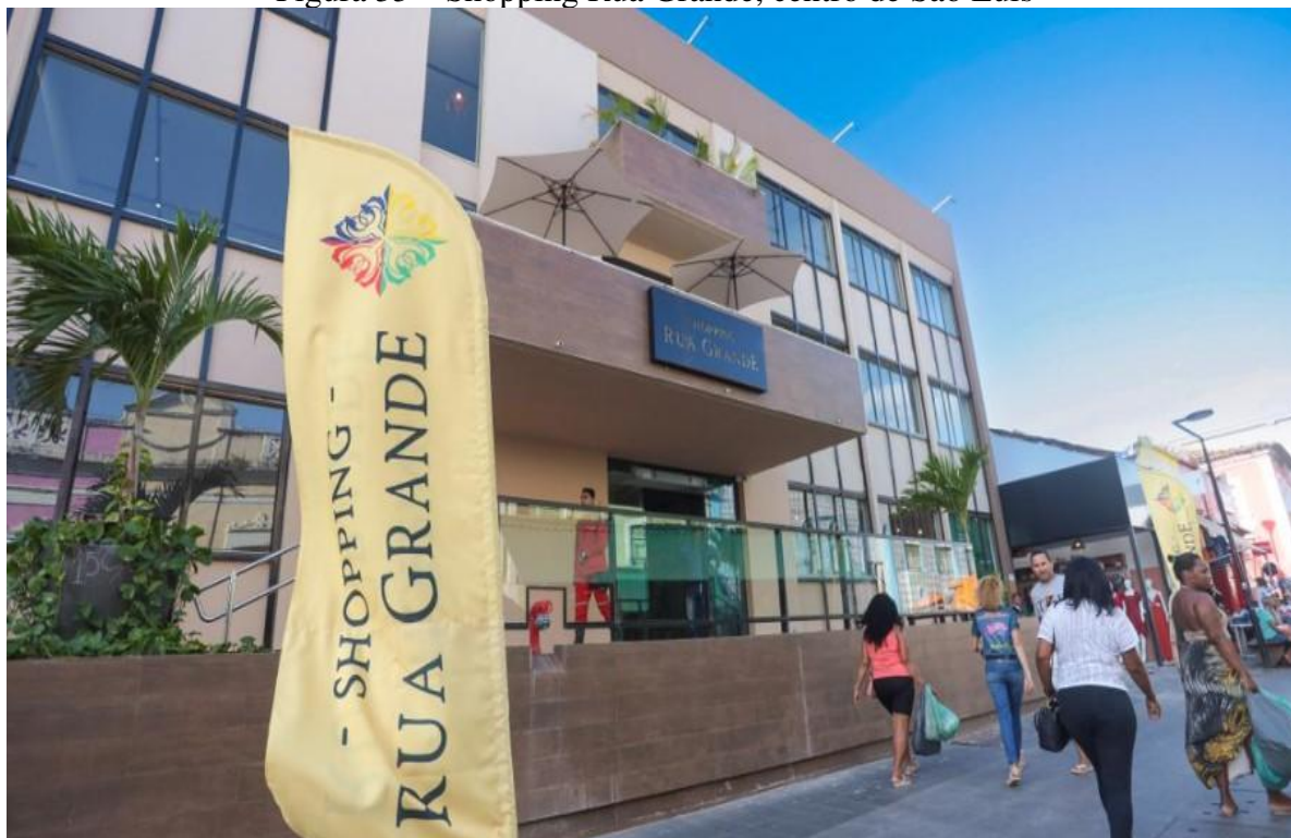
Figura 33 – Shopping Rua Grande, centro de São Luís
