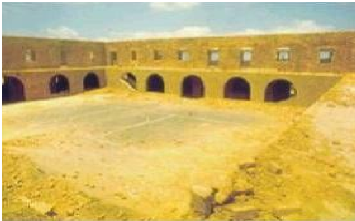
Figura 18 – Convento das Mercês antes de obras do PPRCHSL (1987)
