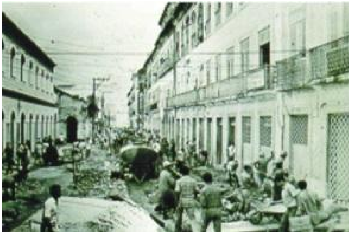
Figura 16 – Rua Portugal em obra, 1987
