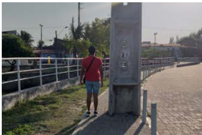
Figura 39 – Foto da calçada com faixa livre ocupada por poste de alta tensão.
