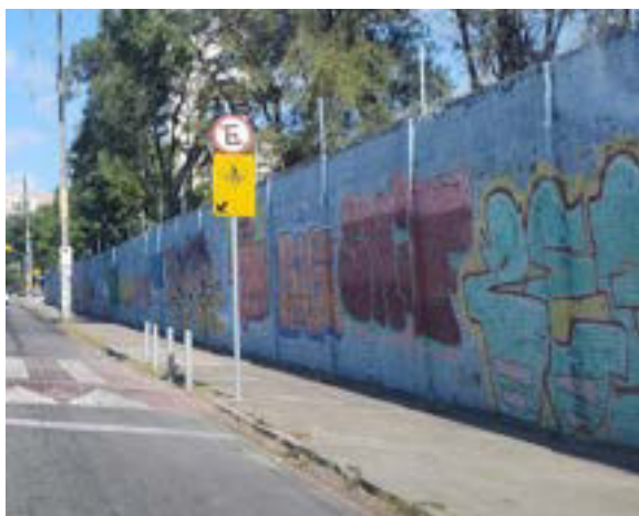
Figura 84 – Foto de muro de colégio na Rua Licurgo Montenegro.
