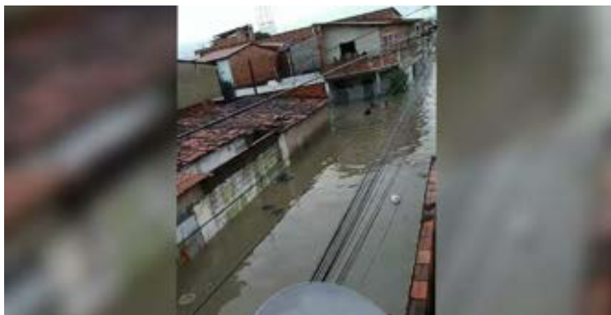
Figura 23 – Foto de rua e casas alagadas no bairro Genibaú após transbordação do Rio Maranguapinho na quadra chuvosa de 2024.
