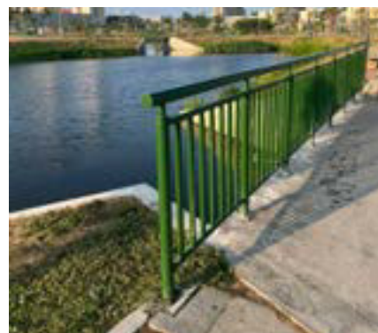
Figura 93 – Foto de guarda-corpo de aduela com sobra de 60cm da área da passagem de água.
