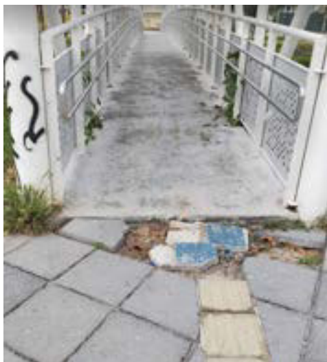
Figura 86 – Foto da chegada do piso tátil à passarela com piso drenante no entorno.
