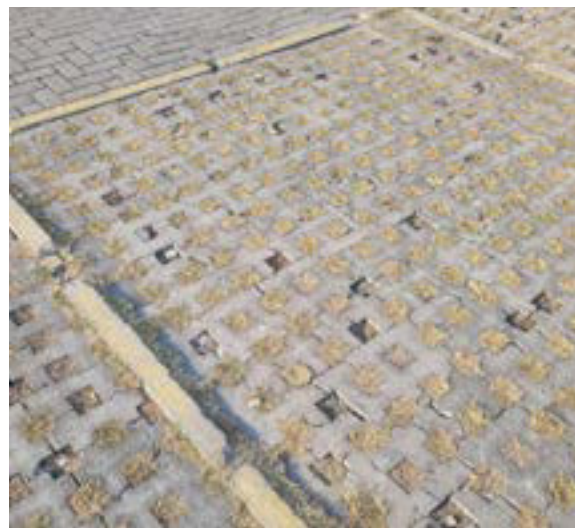
Figura 87 – Foto do concregrama no estacionamento.
