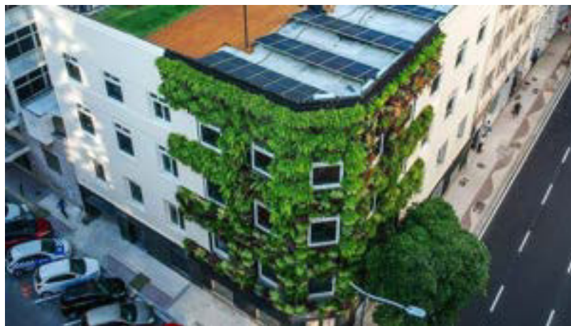
Figura 19 – Foto da Secretaria Municipal de Sustentabilidade, Inovação e Resiliência de Salvador, com jardim vertical, teto verde e painéis fotovoltaicos.
