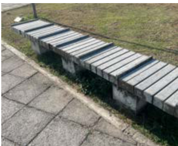
Figura 76 – Foto de banco com divisórias a cada 45 cm, sem encosto ou apoio lateral.
