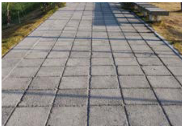
Figura 51 – Foto de área do parque com blocos de piso drenante.
