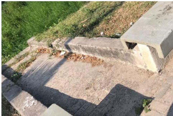
Figura 48 – Foto de um dos canais de escoamento da calçada para o açude.
