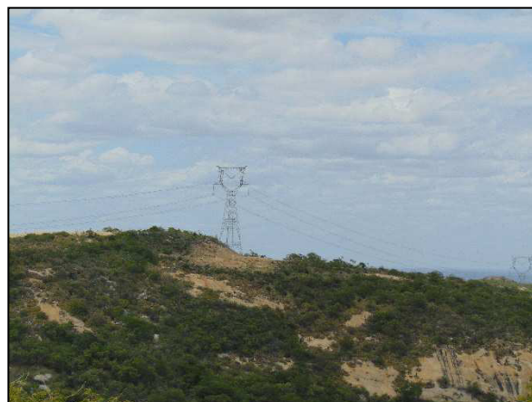
Figura 19 - Linhas de Transmissão (Relevo Alterado)
