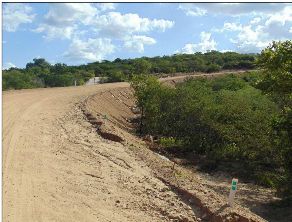
Figura 11 - Aterramento para Construção de Estradas (Santa Luzia-2020)
