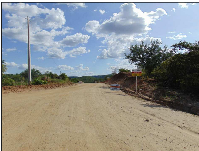
Figura 10 - Abertura de Estradas em Parques Eólicos na Paraíba (Santa Luzia - 2020)
