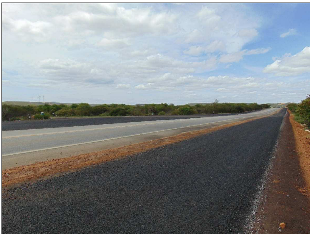
Figura 5 - Alargamento da Rodovia BR-230
