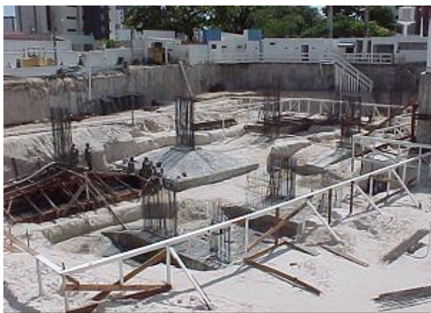
Figura 1 – Execução da fundação vista do escritório
