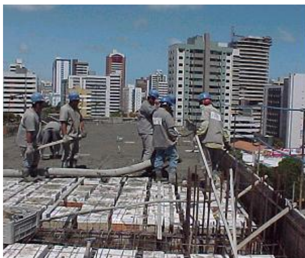
Figura 2 – Concretagem no topo dos blocos cerâmicos e de poliestireno
