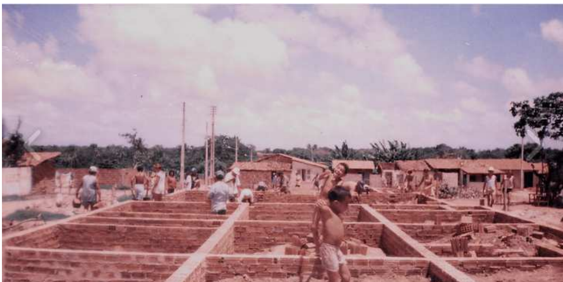
Figura 12 - Construção por meio de mutirão da Comunidade Santa Filomena, Jangurussu
