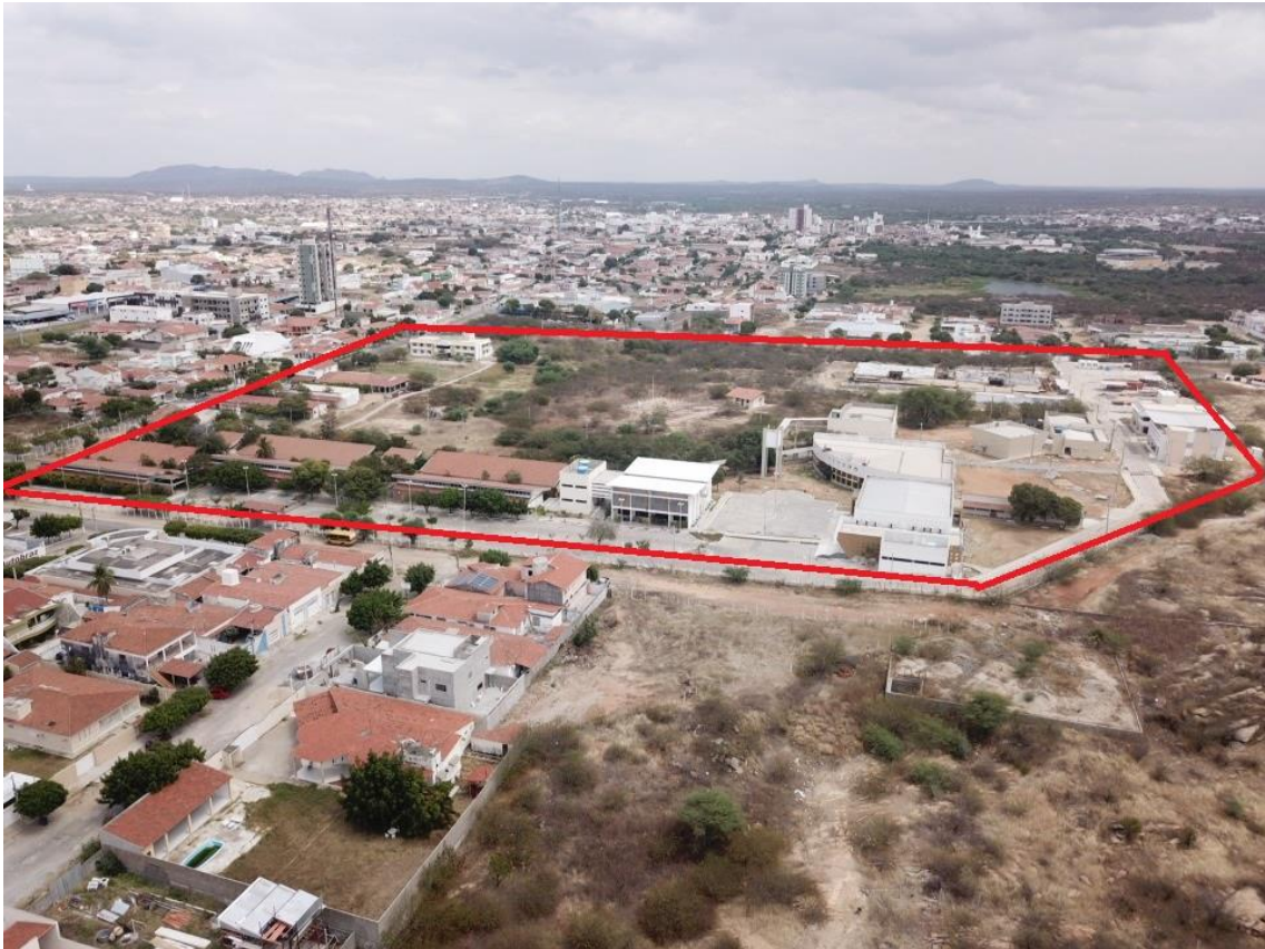
Figura 5 – Imagem aérea do campus Caicó do CERES (Delimitado pelas linhas em vermelho).
