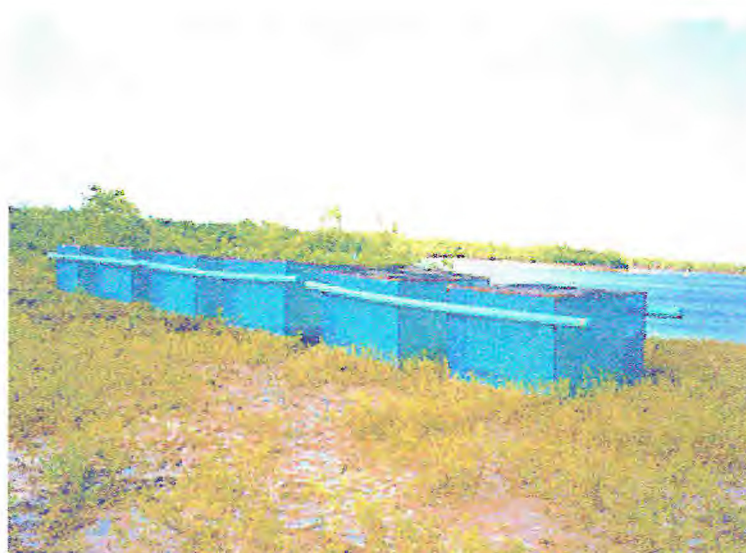
FIGURA 9- Tanques-rede em fileiras de dois em dois, prontos para serem instalados no local de cultivo.
