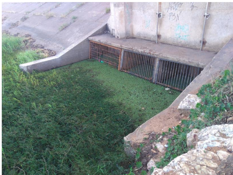
Figura 7 – Tomada d'água do açude Pereira de Miranda, utilizada para o abastecimento da cidade
