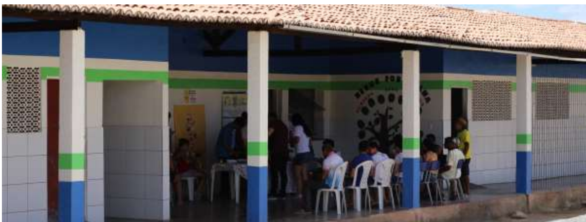
Figuras 3 - Fachada da EEF Francisco Teotônio Alves Pessoa, na comunidade de São Lourenço, em Forquilha, Ceará.
