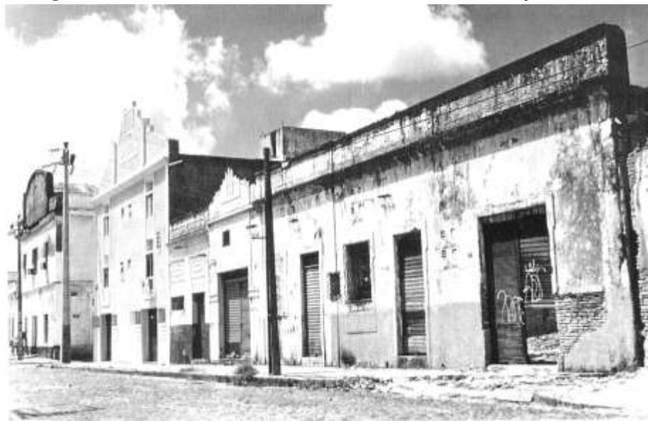
Figura 15 – Edifícios do entorno, fotos anteriores a edificação do CDMAC
