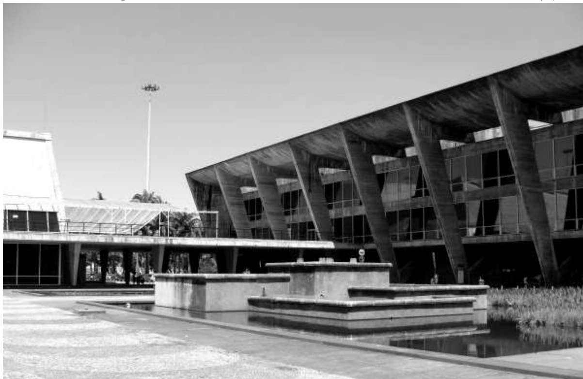
Figura 06 – Museu de Arte Moderna do Rio de Janeiro. Autor: Affonso Reidy (1948)
