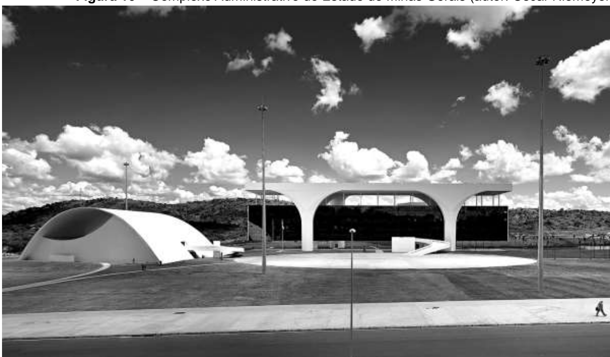
Figura 10 – Complexo Administrativo do Estado de Minas Gerais (autor: Oscar Niemeyer)
