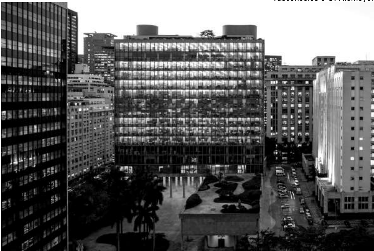
Figura 03 – Ministério da Educação 1936 – 1943 (autores: L. Costa, A. Reidy, J. Moreira, C. Leão, E. Vasconcelos e O. Niemeyer)
