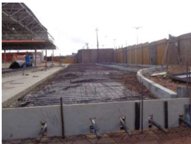
Figura 18 - Posição das barras de transferência
