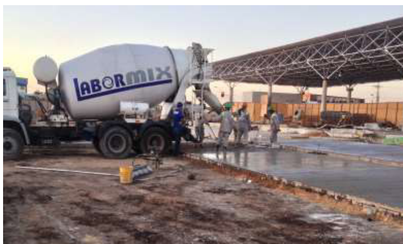
(b) Aplicação de concreto in loco no Terminal Antônio Bezerra (Fonte: AUTOR, 2014)
