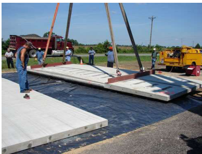
(a) Aplicação de concreto pré-moldado (Fonte: Arquivo U.S.D.T., 2009)
