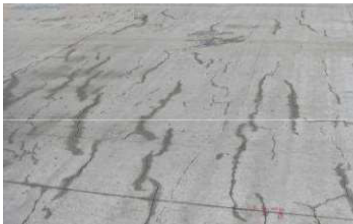
Figura 20 - Fissura por falta de controle na cura
