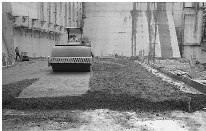
Figura 7 - Execução do CCR
