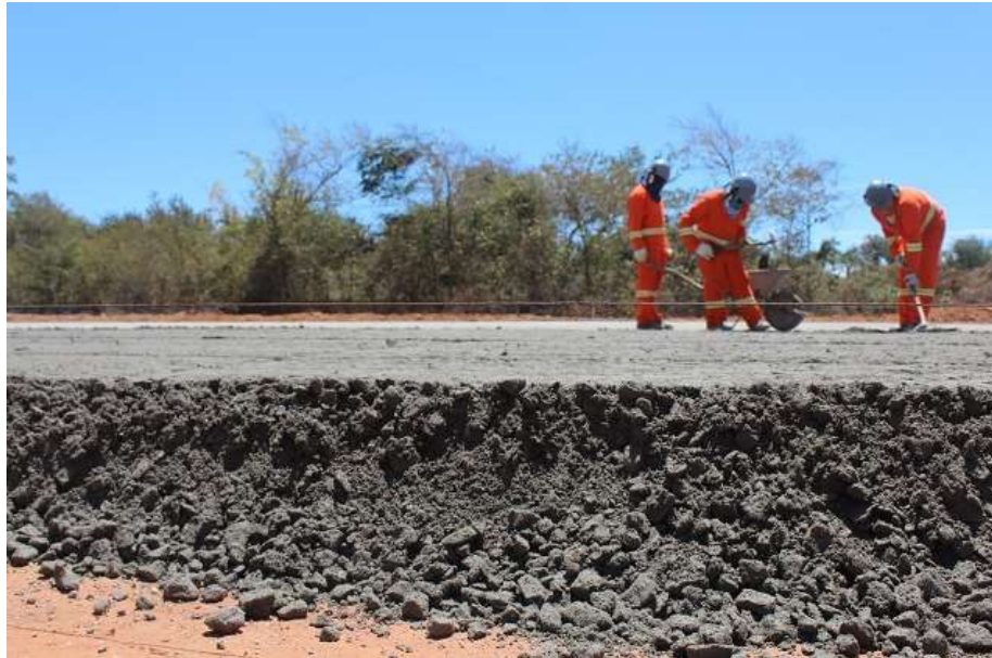
Figura 42 - Camada de concreto compactado a rolo – Ane Viário
