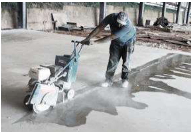
Figura 12 - Execução da serragem das juntas
