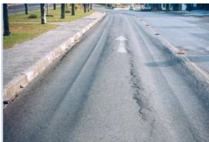
Figura 3 - Deformação permanente (trilha de roda)
