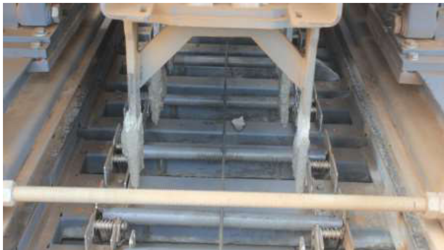
Figura 45 - Inserção de barras de transferência – Anel Viário
