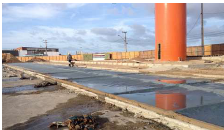
Figura 19 - Uso de mantas geotêxtil para processo de cura
