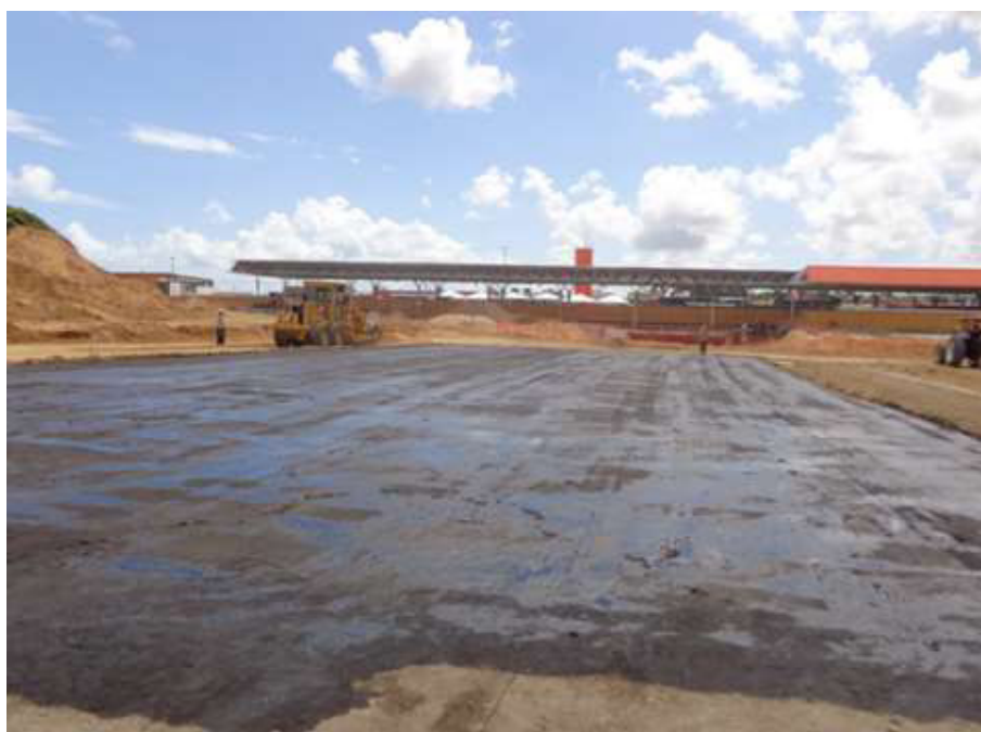
Figura 34 - Imprimação da área de estacionamento do Terminal Antônio Bezerra
