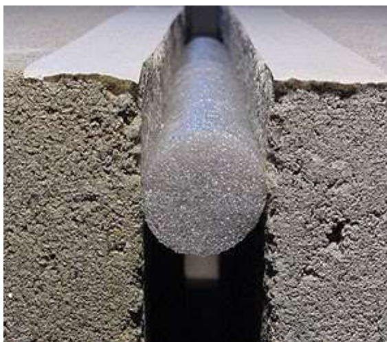
Figura 15 - Detalhe de uma junta de expansão
