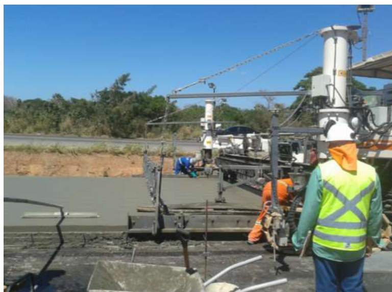
Figura 44 - Nivelamento do concreto – Anel Viário
