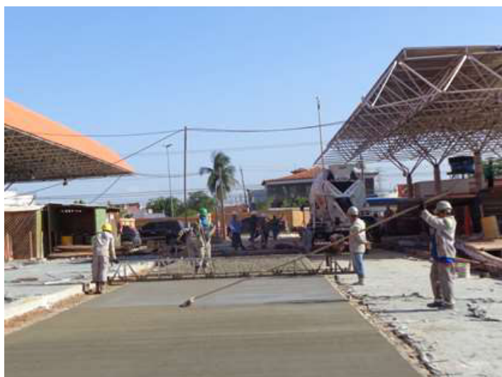
Figura 36 - Execução de frisagem do pavimento de concreto do Terminal
