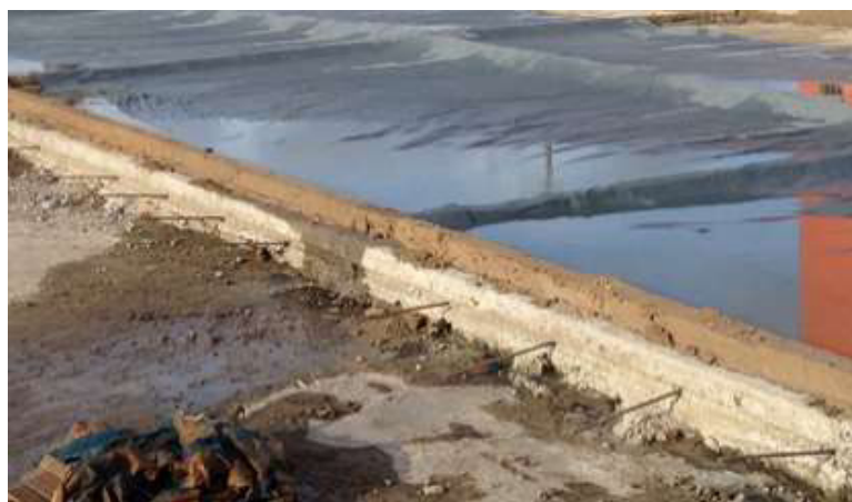
Figura 40 - Disposição das barras de ligação no Terminal Antônio Bezerra
