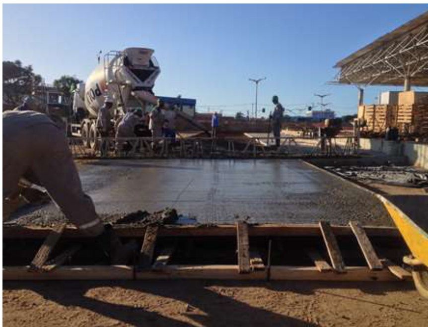
Figura 29 - Aplicação do concreto com uso de régua vibratória
