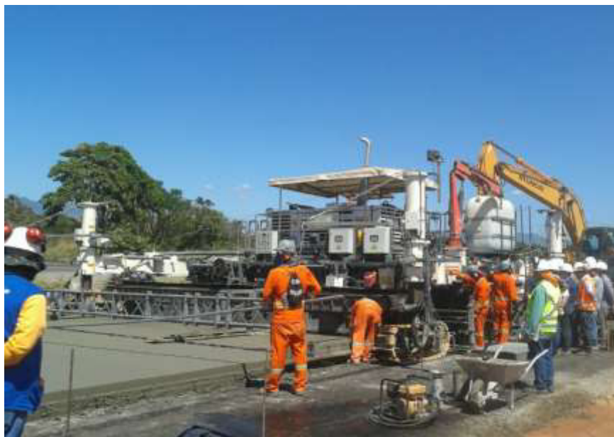
Figura 43 - Pavimentadora de concreto – Anel Viário
