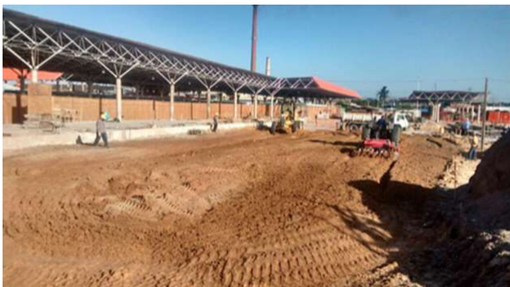
Figura 33 - Equipe de terraplenagem regularizando a fundação
