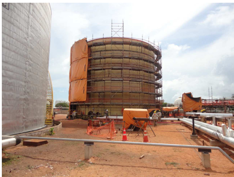
Figura 15 – Execução de pintura
