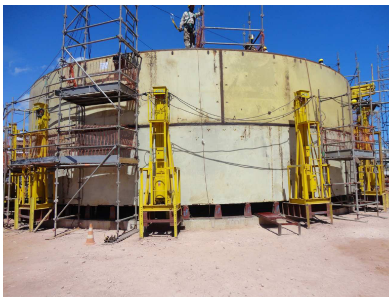
Figura 13 – Colocação das chapas do costado
