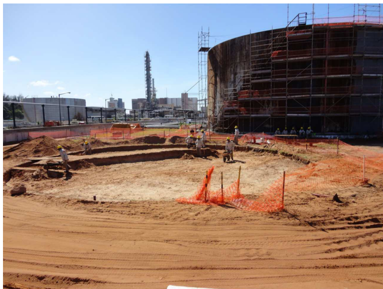
Figura 9 – Execução de movimentação de terra do tanque
