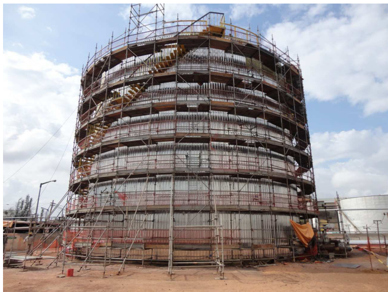
Figura 16 – Execução do isolamento térmico
