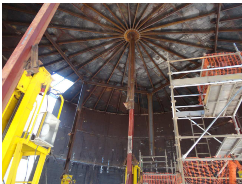
Figura 14 – Teto do tanque de armazenamento
