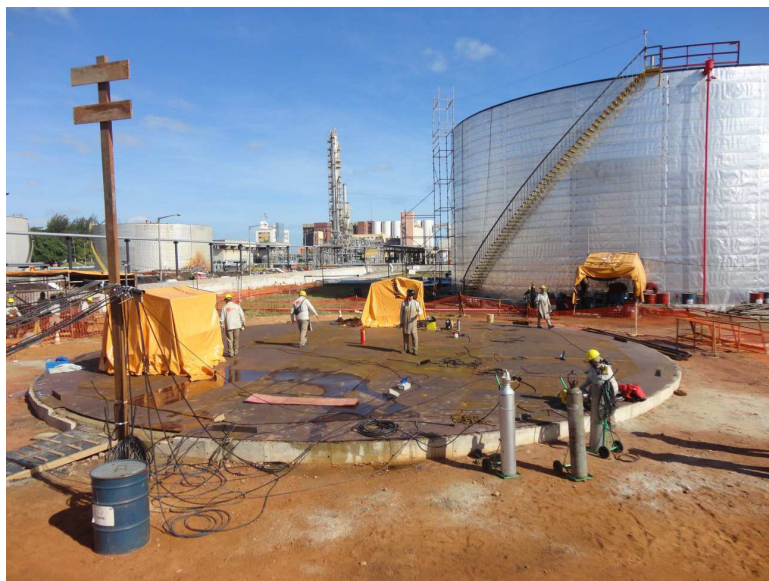
Figura 12 – Colocação das chapas de fundo
