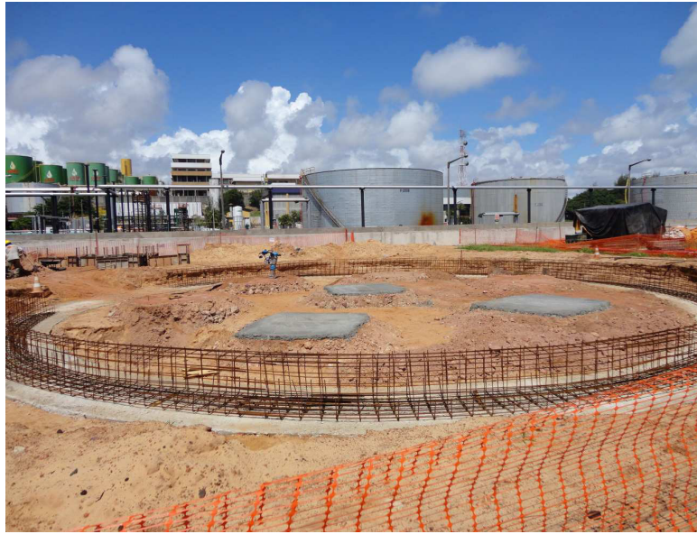
Figura 10 – Execução de anel para fundação
