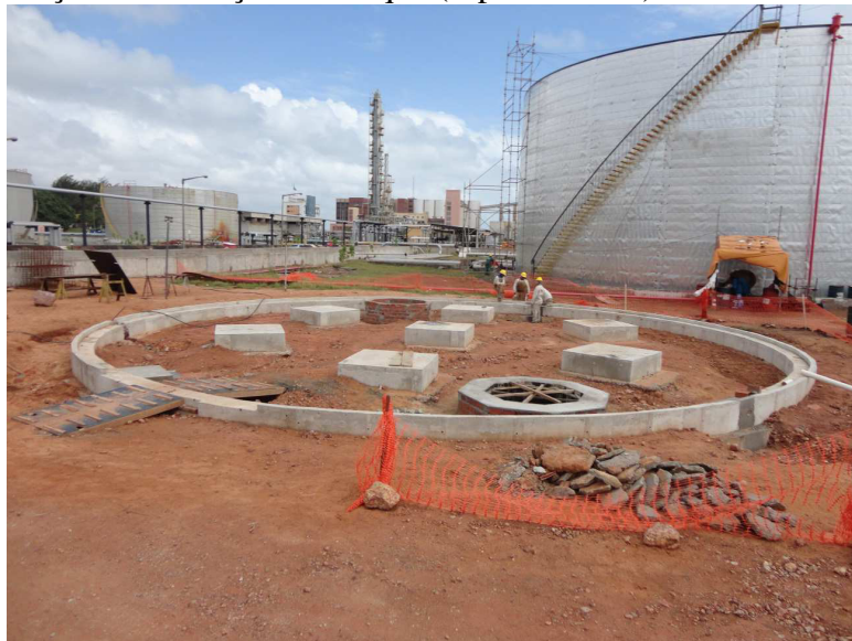
Figura 11 – Finalização de fundação do tanque (sapatas e anel)
