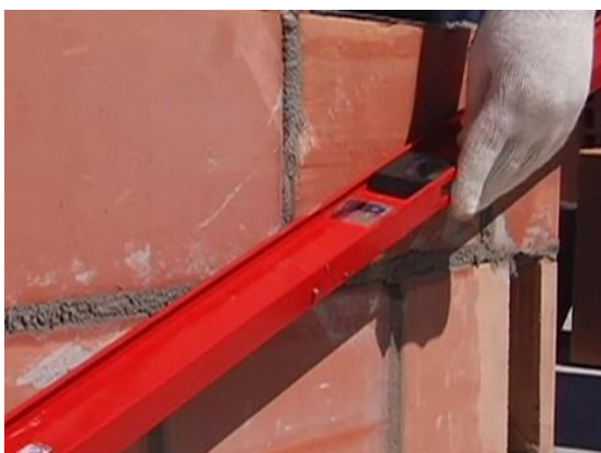
Figura 30 - Régua de prumo e de nível
