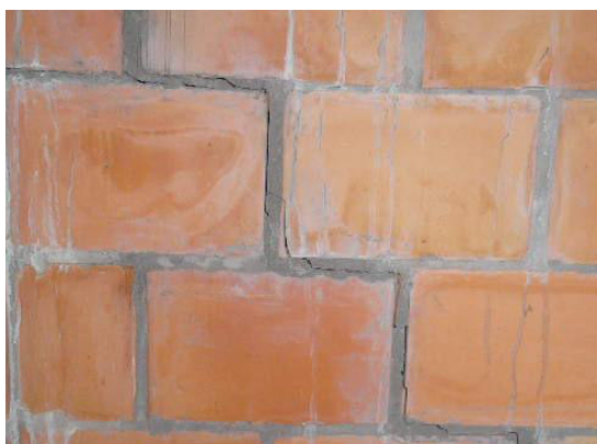
Figura 59 - juntas fissuras
