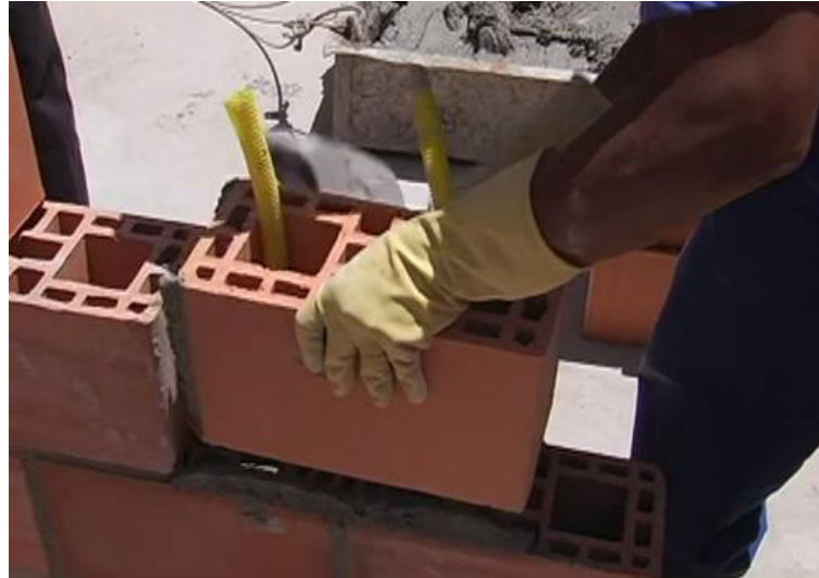
Figura 14 - eletrodutos passando pelo furo dos blocos
