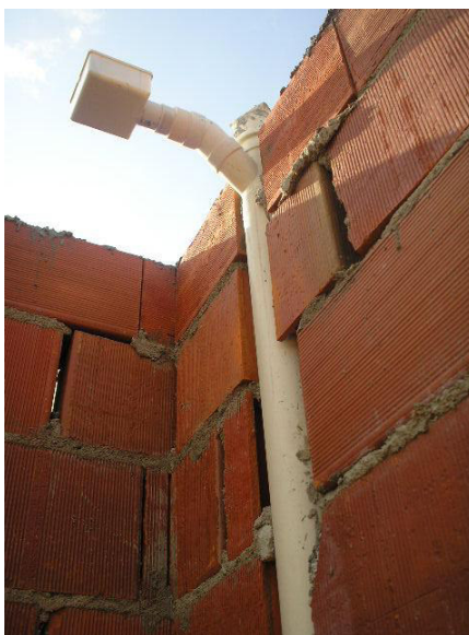
Figura 63 - passagem da instalação hidrossanitária entre os blocos
