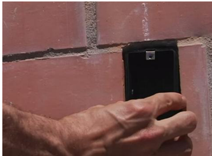
Figura 15 - bloco cortado c/ espera para caixa de tomada
