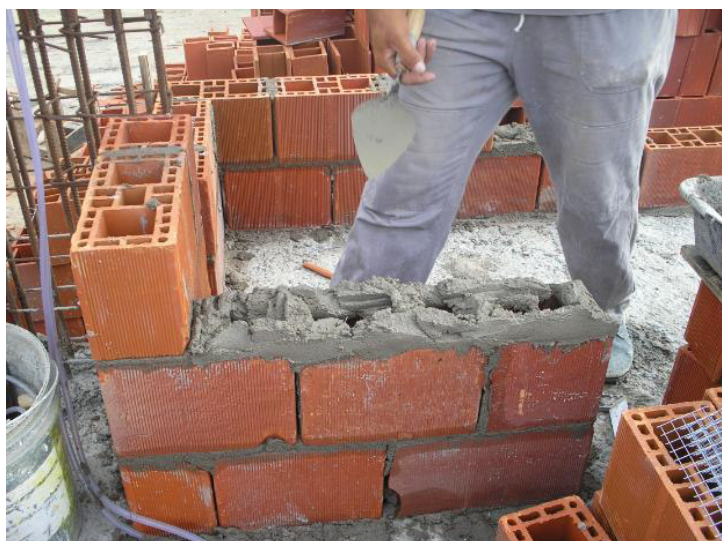
Figura 57 - cordões de argamassa
