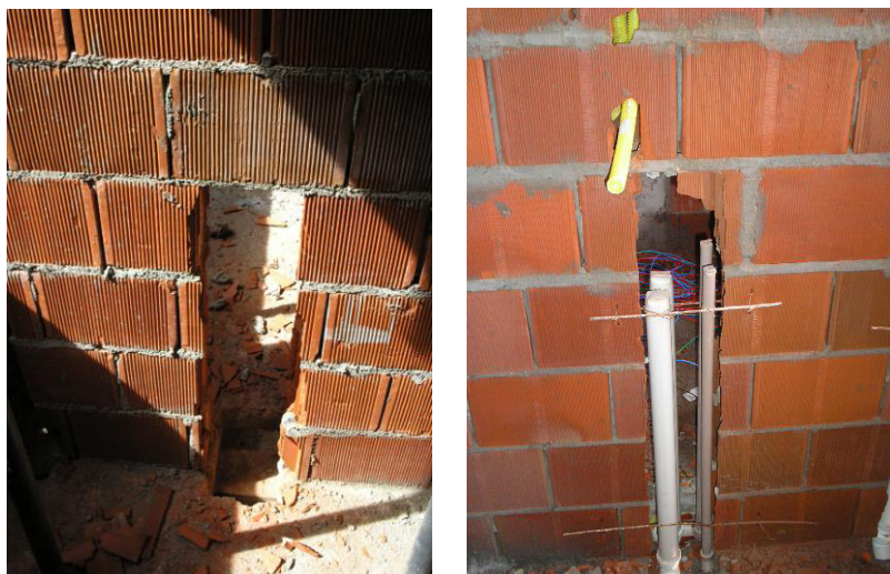
Figura 62 - quebra de blocos para passagem de tubulação hidráulica
