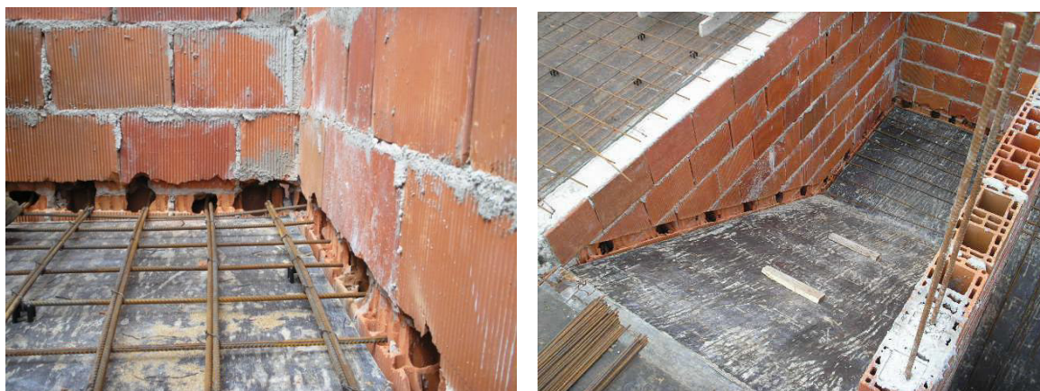
Figura 61 - rasgos na alvenaria da parede da escada
