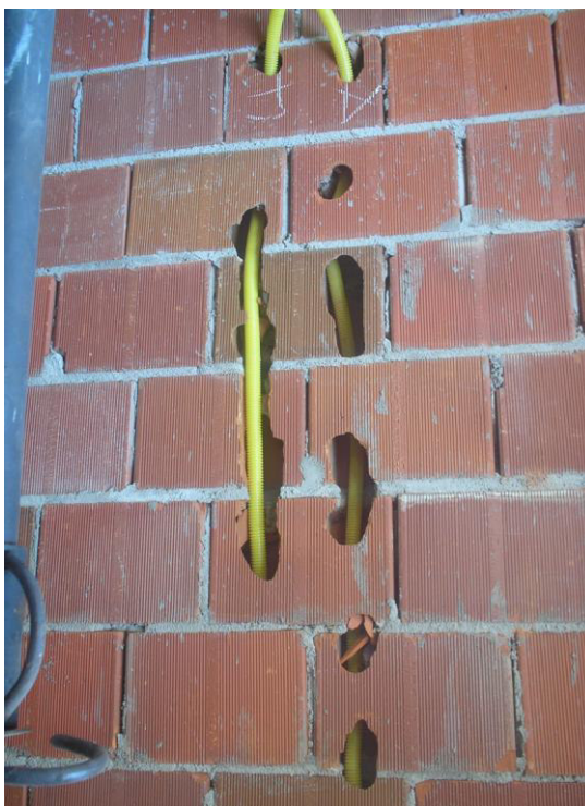
Figura 58 - descida dos eletrodutos dentro dos blocos
