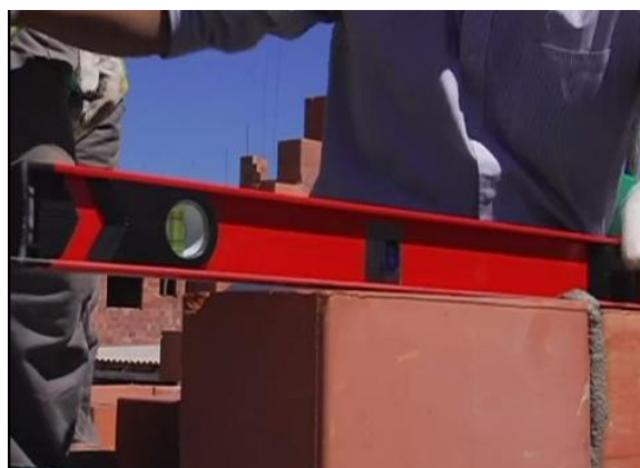
Figura 31 - Régua de prumo e de nível
