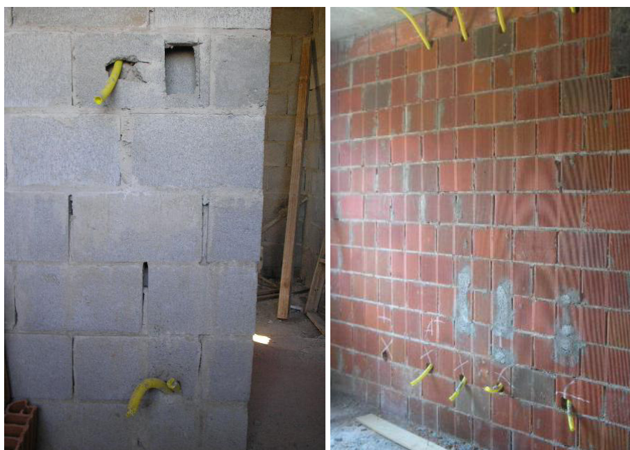
Figura 60 - Quebra em parede resultante de encaixe posterior de eletroduto e caixa de espera
