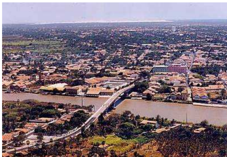
Fig. 4 - Vista aérea da Ponte Simplício Dias
