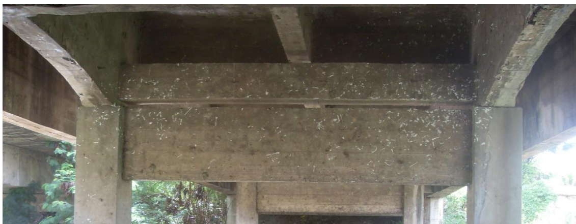
Figura 23 - Transversina da ponte em estudo
