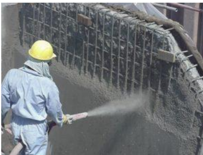
Figura 17 - Exemplo de aplicação de concreto projetado
