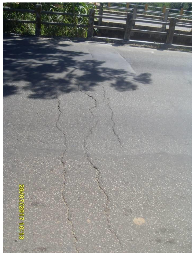
Figura 8 – Fissuras no pavimento
