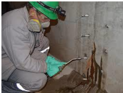
Figura 18 - Preenchendo fissuras com poliuretano
