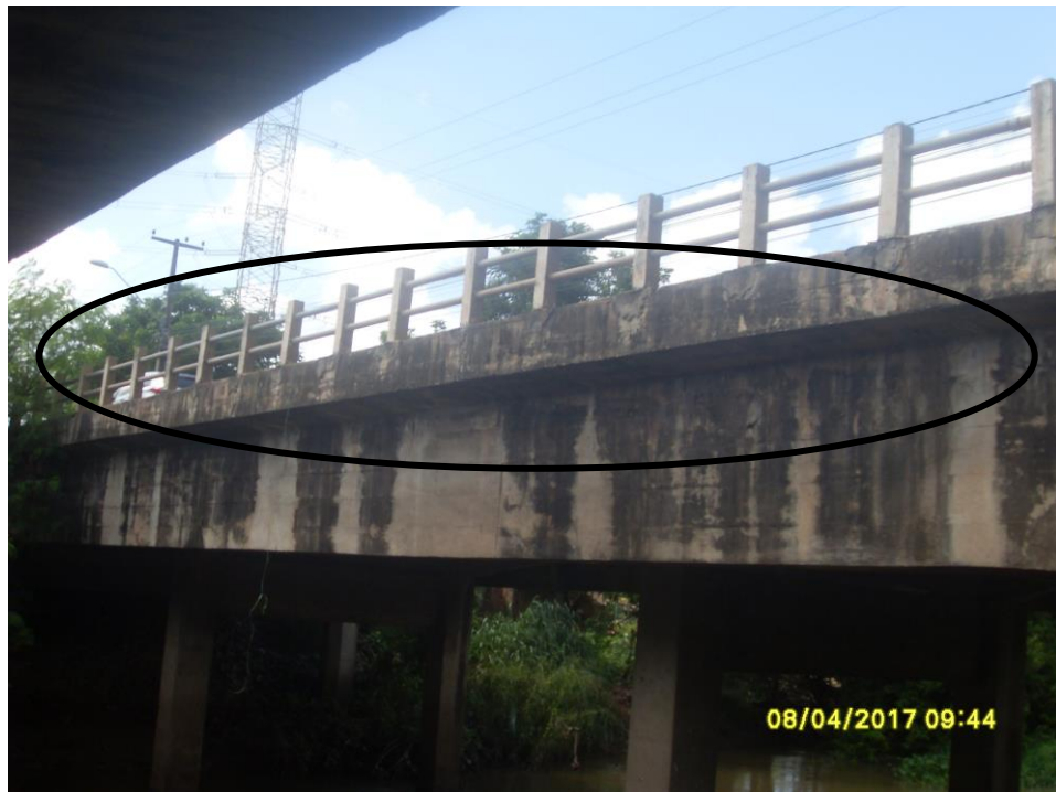
Figure 9 – Ausência ou entupimento dos drenos da ponte
