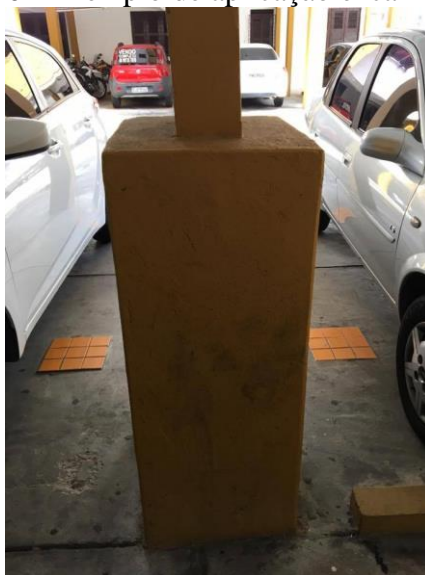
Figura 20 - Exemplo de aplicação encamisamento
