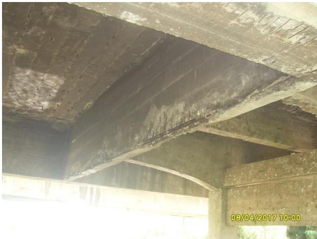
Figura 1 – Armadura exposta da transversina e fissuras na longarina
