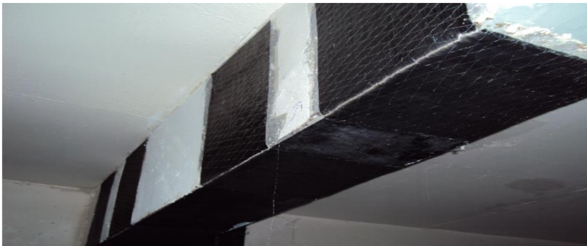
Figura 19 - Exemplo de aplicação de fibra de carbono
