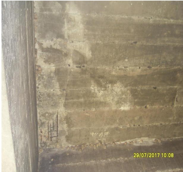
Figura 5 – Desgaste e armadura exposta na laje do tabuleiro
