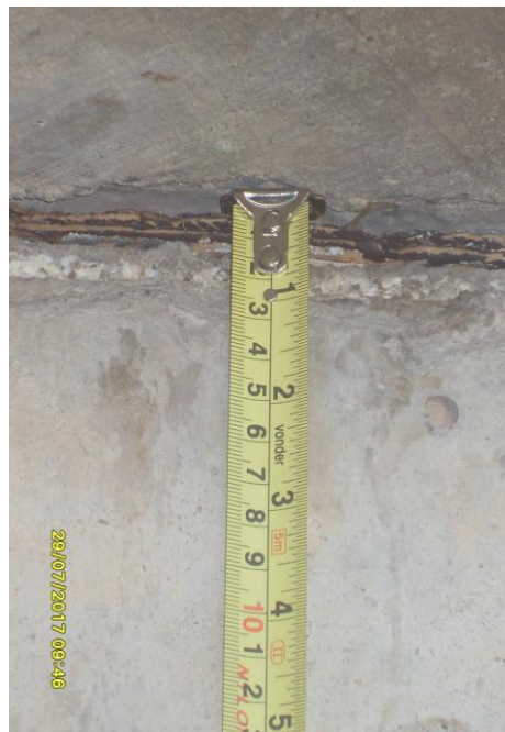
Figura 13- Neoprene aparentemente esmagado
