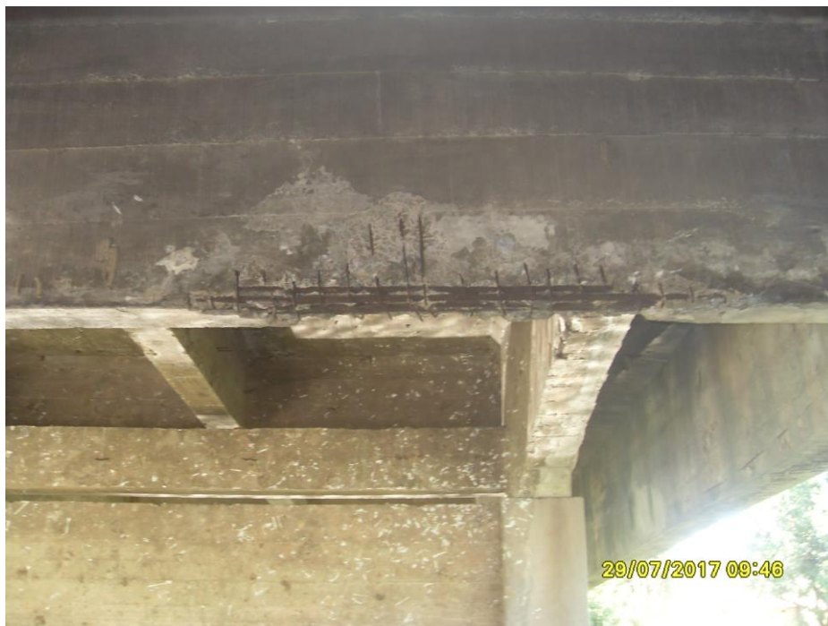
Figura 10 - Exemplo de corrosão e exposição de armadura da ponte
