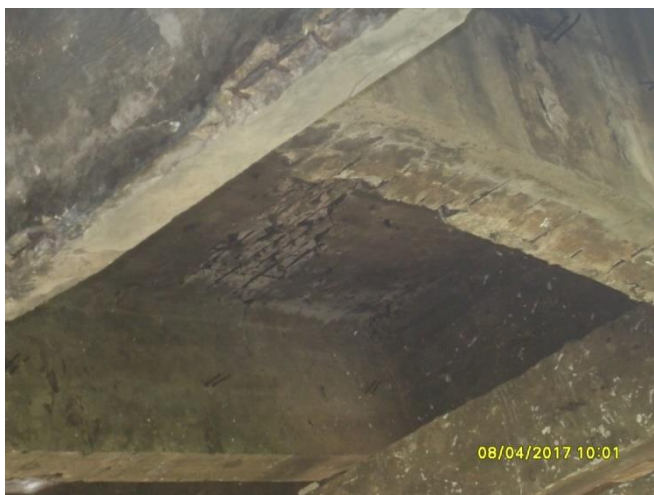
Figura 7 – Armadura exposta na laje do tabuleiro
