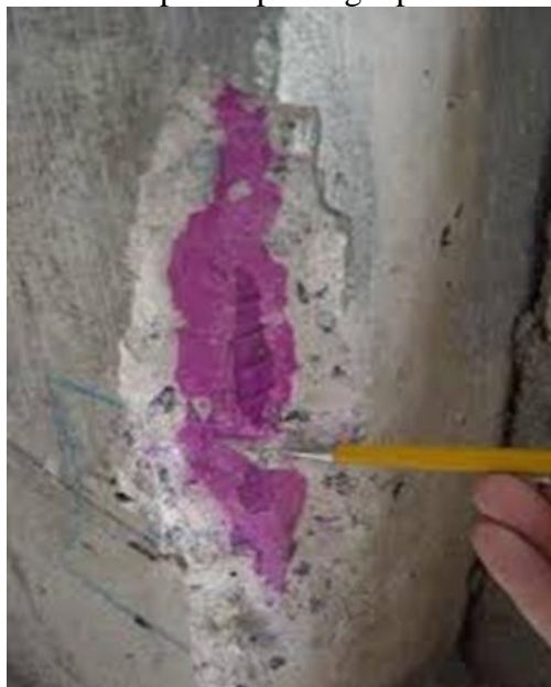
Figura 8 - Exemplo de patologia por carbonatação
