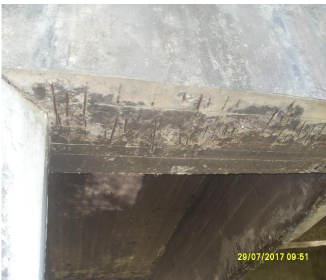
Figura 3 – Armadura exposta na longarina
