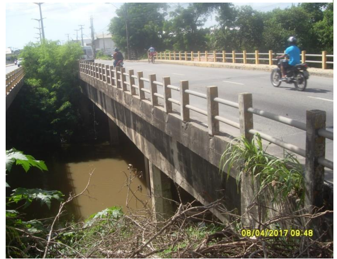
Figura 6 – Guarda-corpo em boas condições
