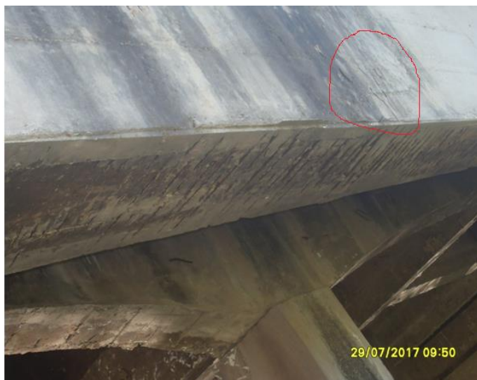
Figura 11 - Fissura na longarina da ponte
