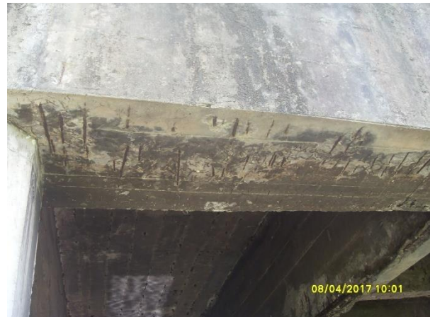
Figura 2 – Fissuras na longarina
