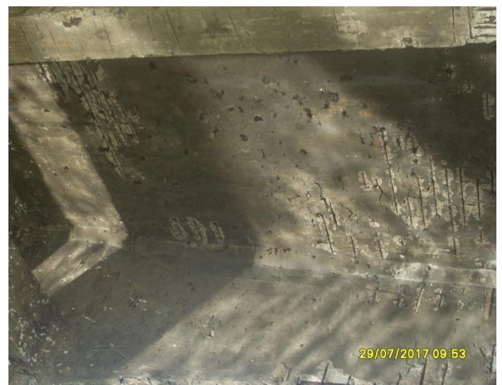
Figura 4 – Armadura exposta na laje do tabuleiro
