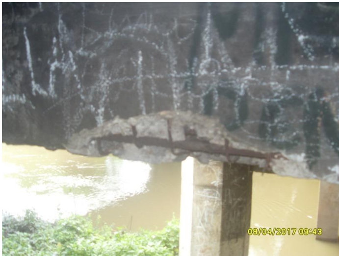
Figura 5 – Armadura exposta da transversina
