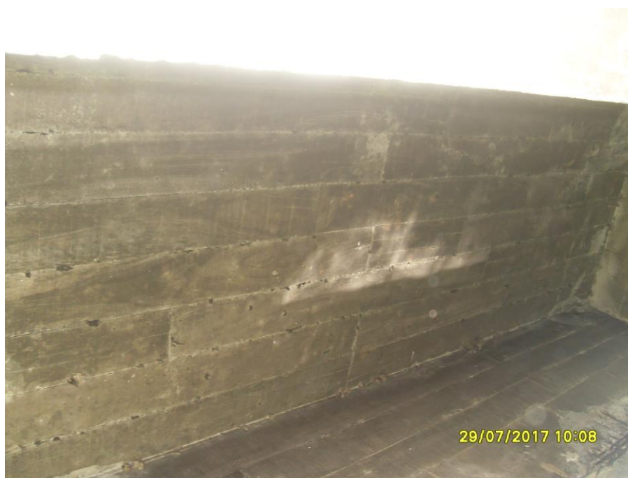
Figura 9 - Exemplo de desgaste da laje do tabuleiro da ponte
