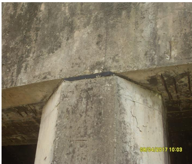
Figura 3 – Esmagamento do elemento de apoio
