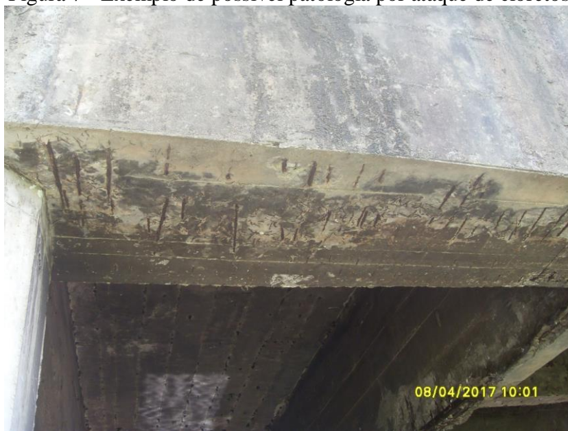
Figura 7 - Exemplo de possível patologia por ataque de cloretos
