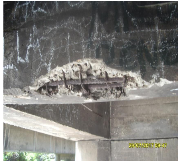
Figura 6 – Armadura exposta na viga próxima ao encontro
