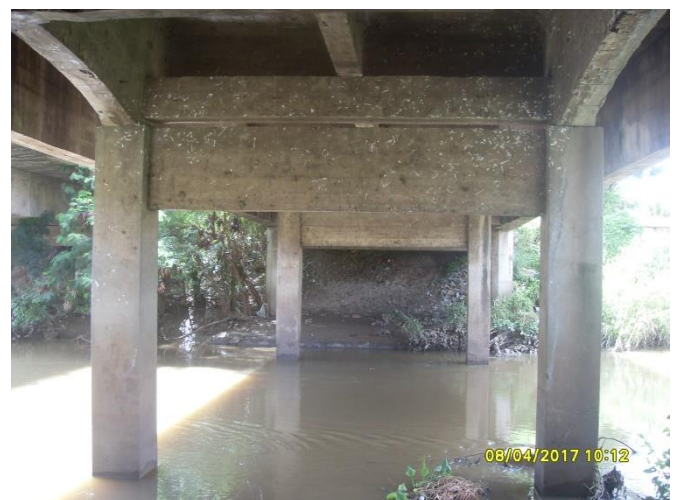
Figura 8 – Pilares em boas condições
