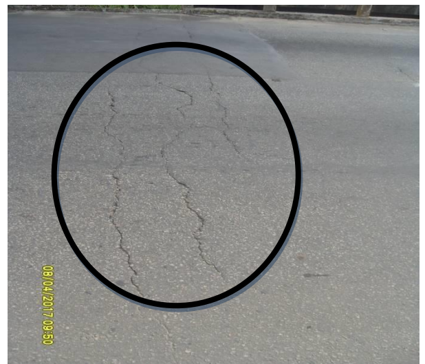
Figura 4 – Fissuras no pavimento
