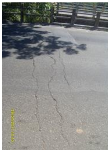
Figura 12 - Fissura no pavimento da ponte
