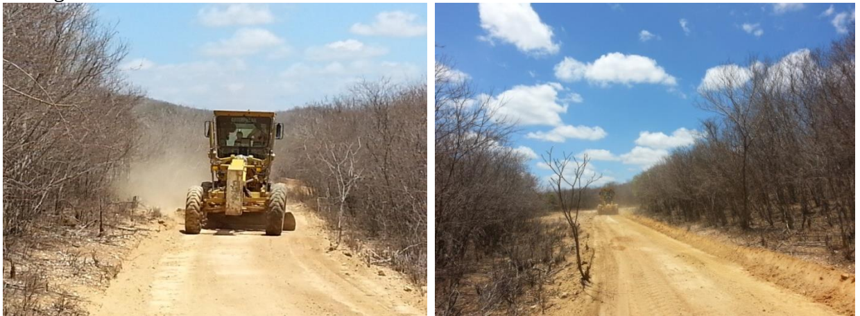
Figura 4 – Manutenção de superfície de estrada não pavimentada na Bacia do Benguê, via que interliga as comunidades rurais Gameleira e Aroeira
