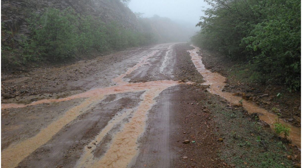
Figura 3 – Estrada não pavimentada na Bacia Hidrográfica do Benguê, via que interliga as comunidades rurais Barra e Cedro no município de Aiuaba, durante evento pluviométrico de grande magnitude (Janeiro/2016)
