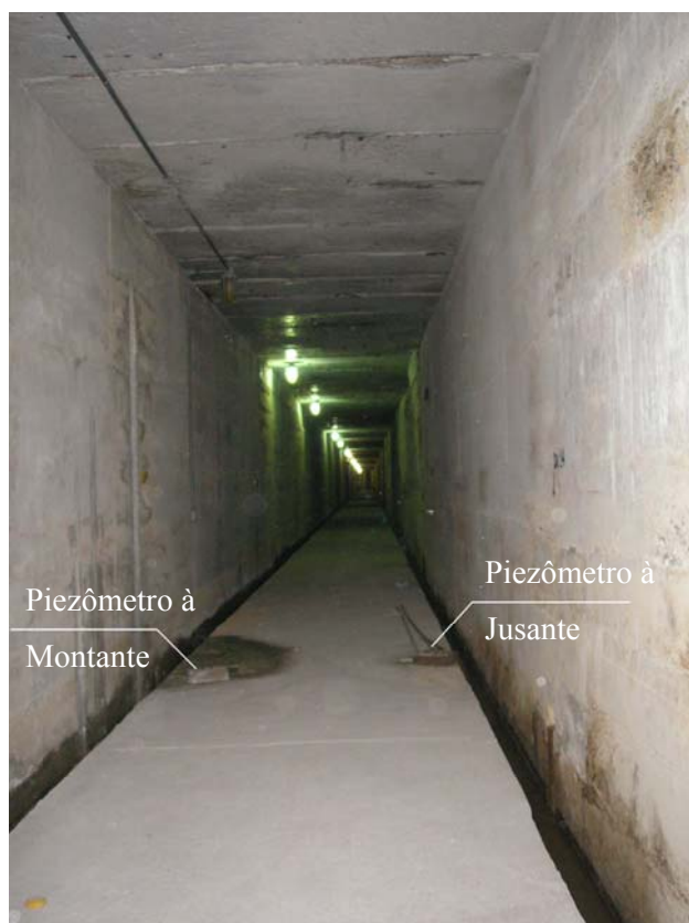
Figura 3.12 – Galeria de drenagem da fundação, com localização de piezômetros a montante e à jusante.
