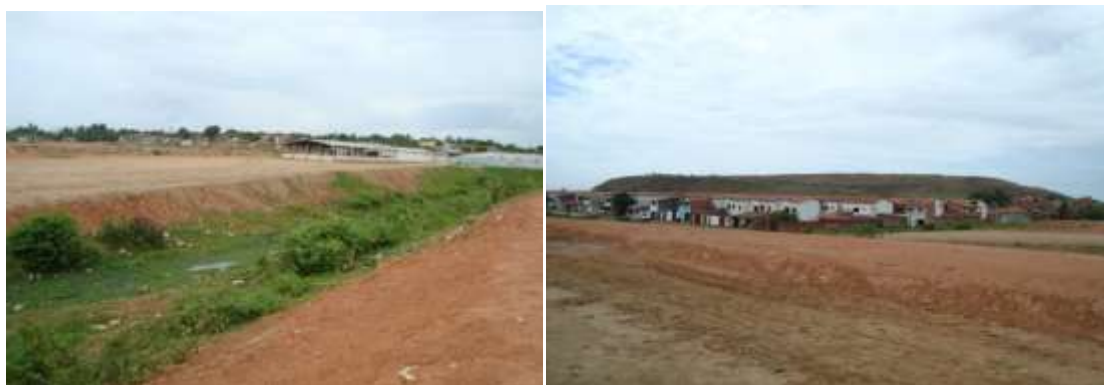
Figura 22 - Aterro de áreas alagadas para construção do novo conjunto habitacional na planície do Rio Cocó. Fonte: acervo próprio, abril de 2010.
