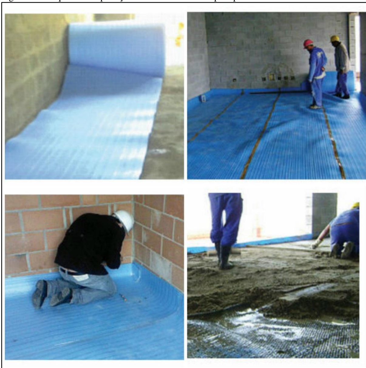
Figura 23 - Esquema de aplicação do isolante acústico para pisos
