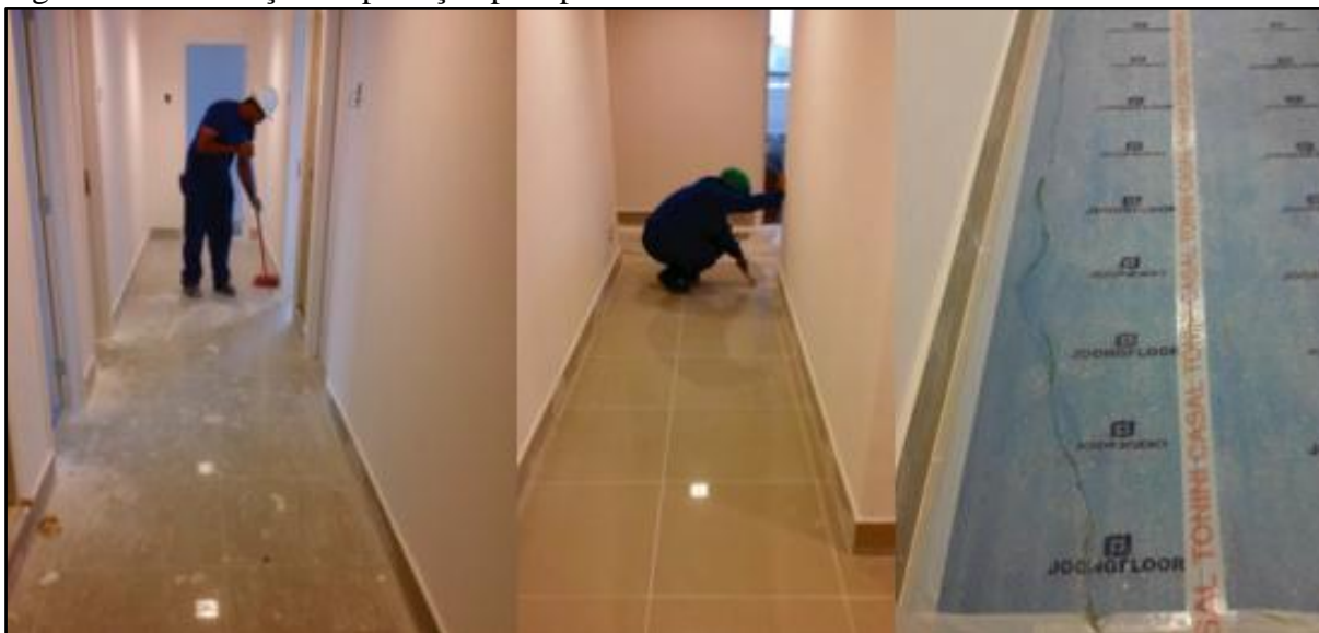
Figura 24 - Utilização da proteção para pisos acabados
