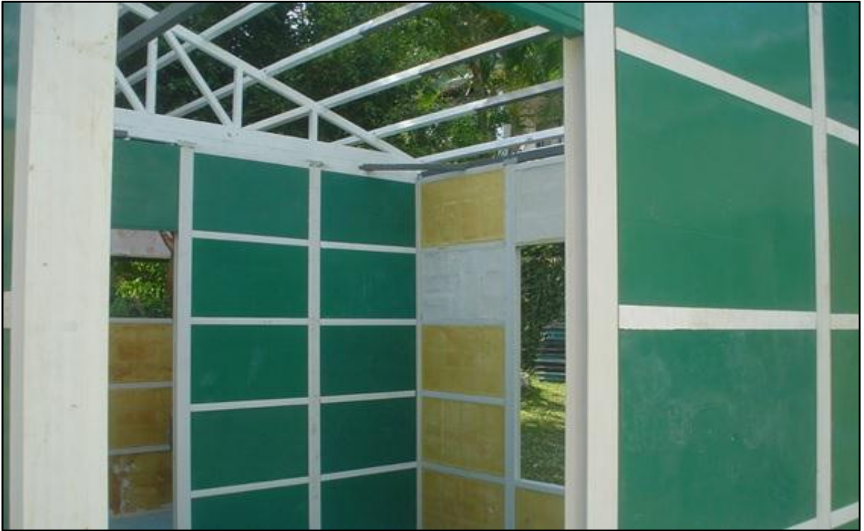
Figura 13- Vista estrutura da casa de plástico
