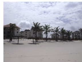
AVANÇO DAS CONSTRUÇÕES
