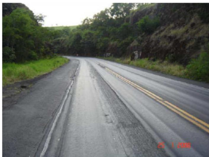
A deformação permanente nos revestimentos asfálticos é caracterizada por depressões longitudinais nas trilhas de roda, as quais aumentam com as cargas repetidas impostas pelo tráfego de veículos (MAHMOUD e BAHIA, 2004). Para combater este tipo de defeito em misturas asfálticas se recorre, sobretudo, a agregados com propriedades específicas como alta angularidade, forma cúbica e textura rugosa, como também a utilização de ligantes asfálticos modificados.
